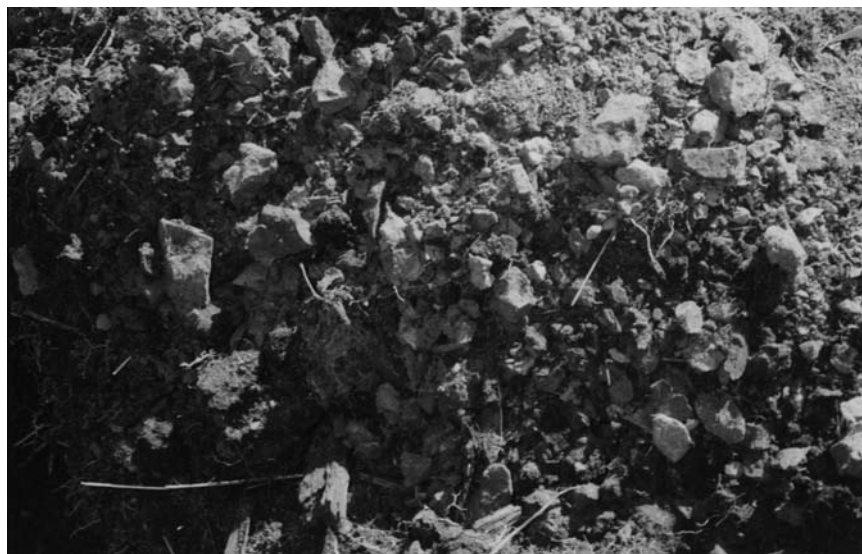
Fot. 1. Grunt zdegradowany (zbrylony) w wierzchniej warstwie obwałowania Fiszewki
