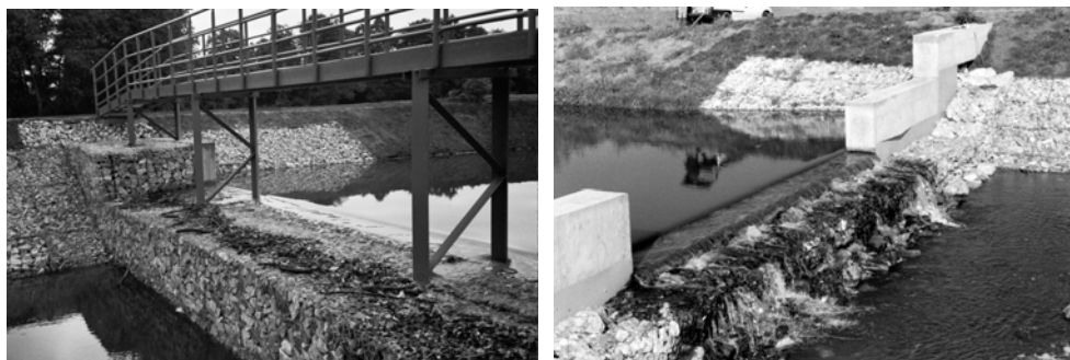
Fot. 4. Stopnie z gabionów wykonane w korycie Wilgi i Radomki (projekt Bipromel)
