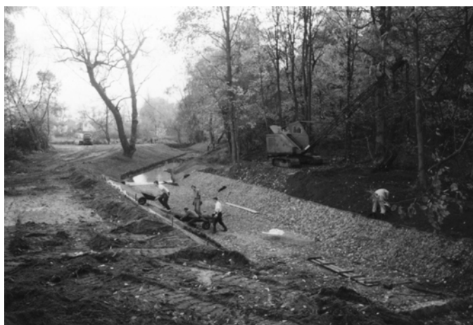
Fot. 1. Bystrotok z elementów siatkowo-kamiennych w korycie Skrwy (faza budowy)
