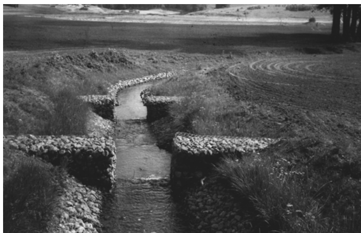
Fot. 3. Stopnie gabionowe na odpływie ze źródeł w okolicach Połczyna Zdroju (projekt Bipromel [Stopnie ..., 2001])
