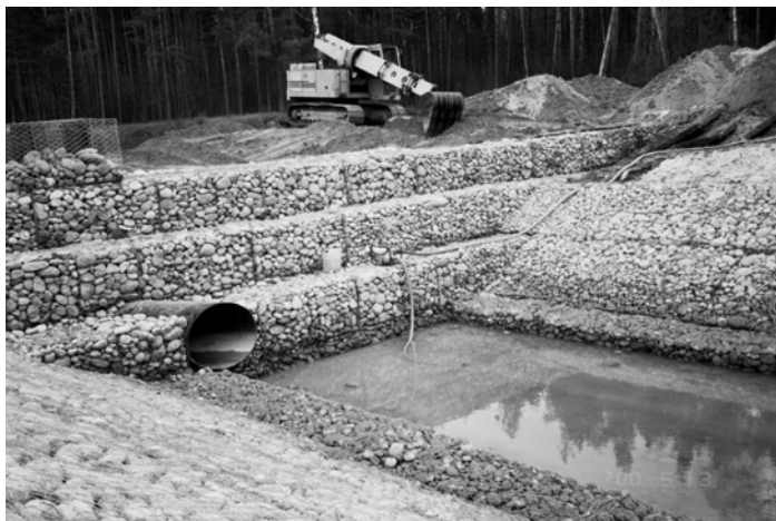
Fot. 2. Zapora z gabionów z budowlą spustową na rzece Szum [Zbiornik ..., 2001]
