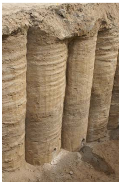
Fot. 2. Pionowe pale tworzące przegrodę przeciwfiltracyjną wykonaną metodą wgłębnego mieszania (fot. J. Rycharska)
