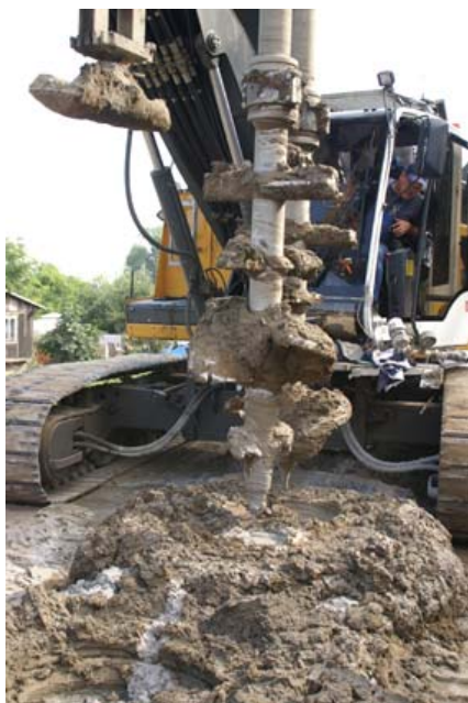
Fot. 1. Wykonywanie przesłony przeciwfiltracyjnej metodą wgłębnego mieszania (fot. J. Rycharska)
