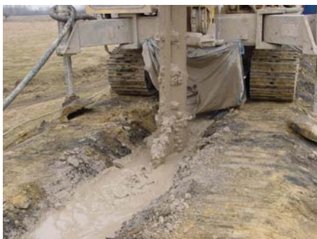
Fot. 3. Wykonywanie przesłony przeciwfiltracyjnej metodą wibracyjną (fot. M. Borys )
