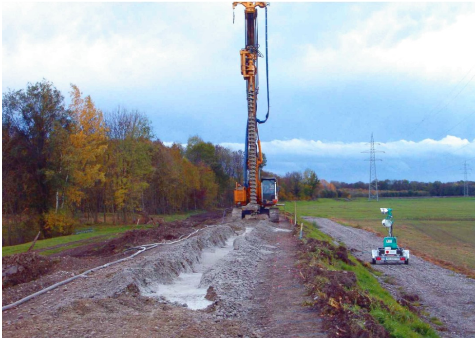
Rys. 2. Wykonywanie przegrody filtracyjnej metodą Mixed-In-Place (widok maszyny wykonującej przegrodę)
