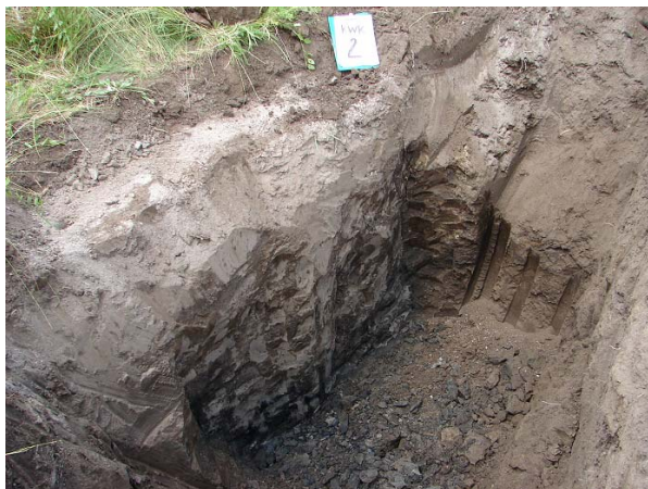
Fot. 2. Widok przegrody przeciwfiltracyjnej w obwałowaniu Kanału Wieprz-Krzna po 4 latach eksploatacji (fot. M. Borys )
