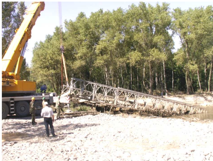
Rys. 4. Usuwanie stalowej konstrukcji mostu z rz. Witka w m. RADOMIERZYCE
