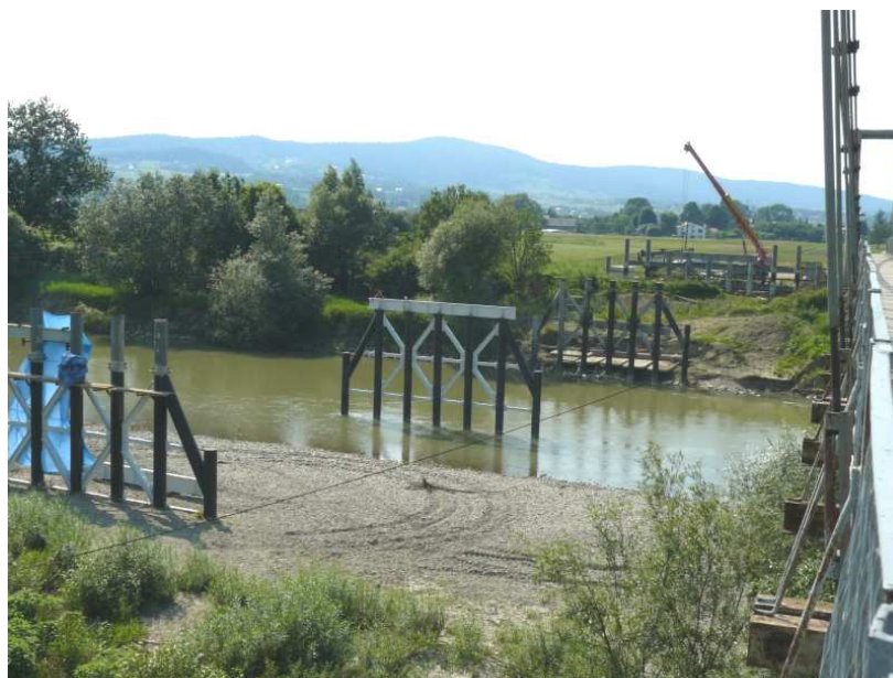
Rys. 5. Budowa mostów (wykonanie podpór) na rz. Wisłok w m. KOŁACZYCE
