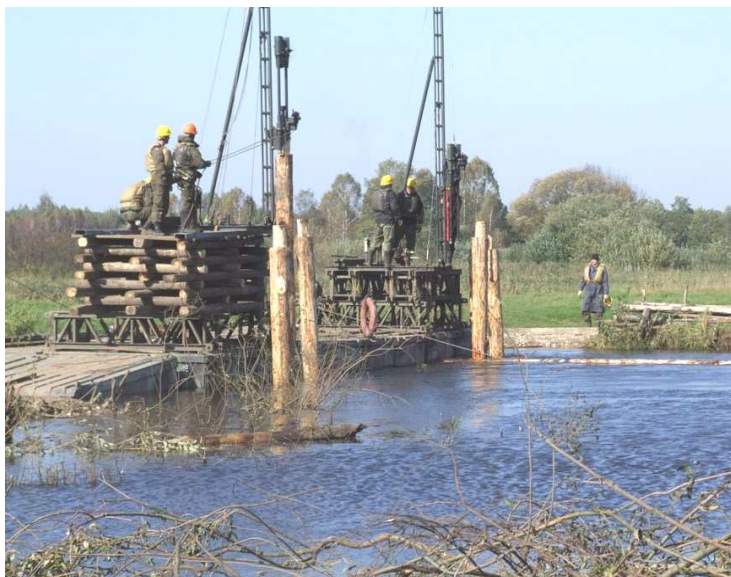
Rys. 2. Budowa mostu na rz. Pilica w m. CHAŁUPY
