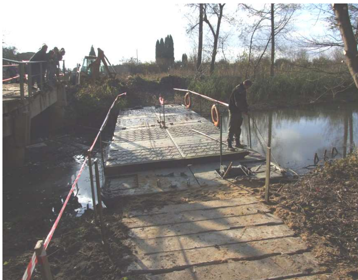
Rys. 3. Budowa tymczasowej przeprawy z PP-64 w gminie WILKÓW
