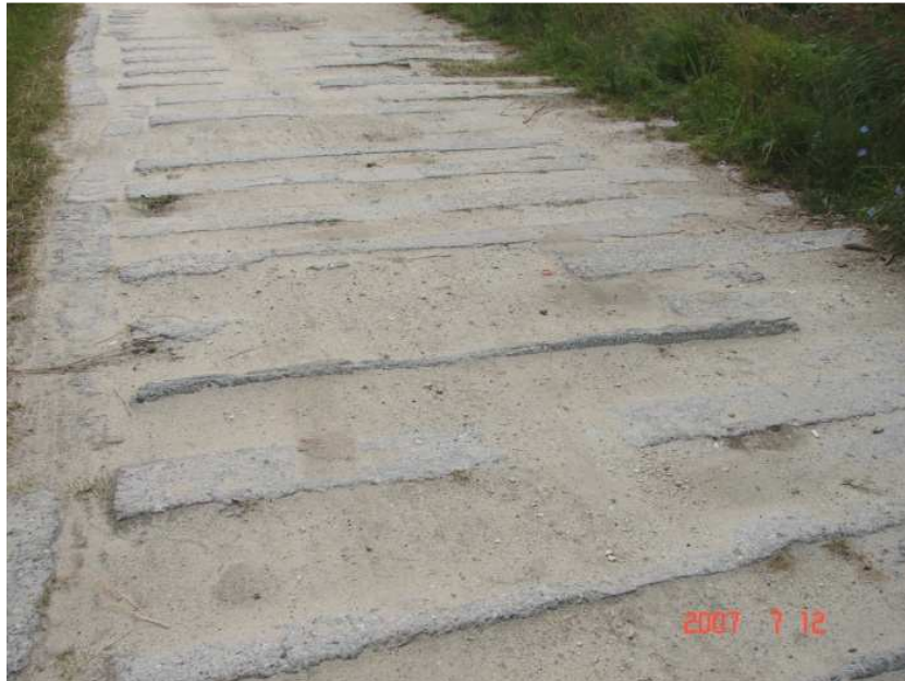
Rys. 1. Odcinek pomiarowy drogi z nawierzchnią z podkładów kolejowych
