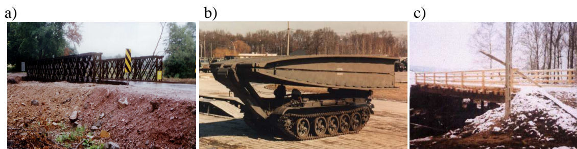
Rys. 6. Przykłady mostów wojskowych: a) składanego, b) towarzyszącego i c) niskowodnego.
