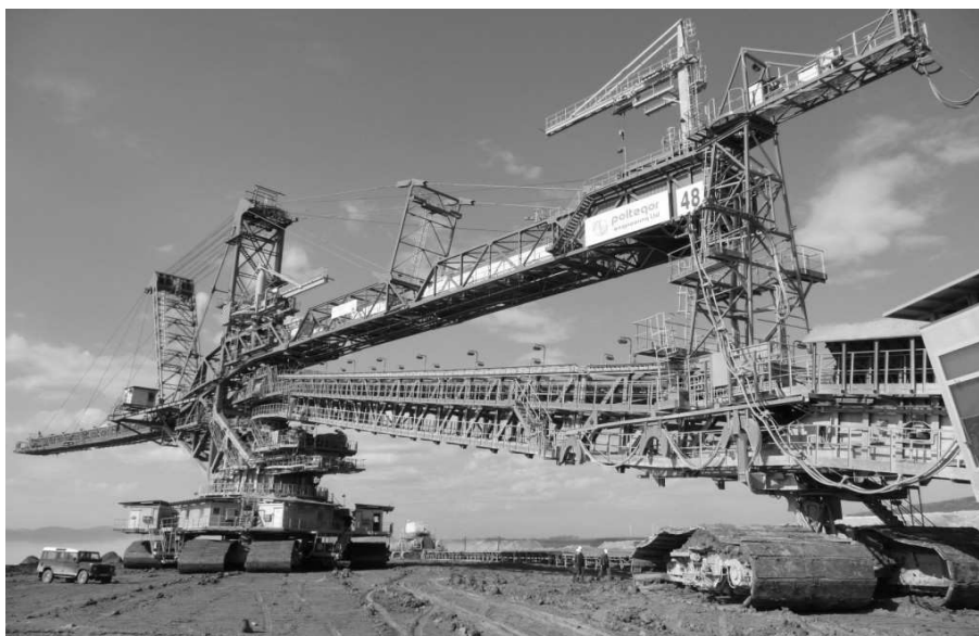
Rys. 1. Widok mostu zwałowarki
