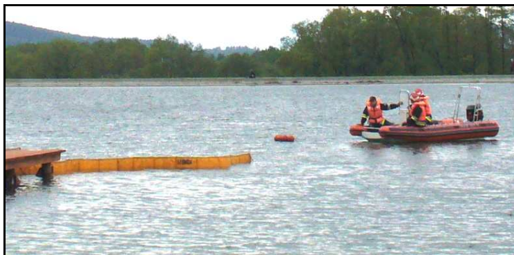
Rys. 62. Ustawianie zapory elastycznej za pomocą jednostki pływającej
