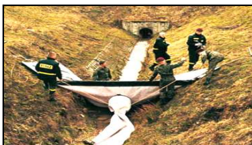
Rys. 59. Przegroda spiętrzająca
