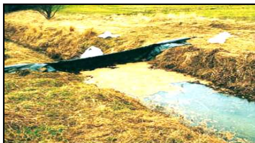
Rys. 59. Przegroda spiętrzająca
