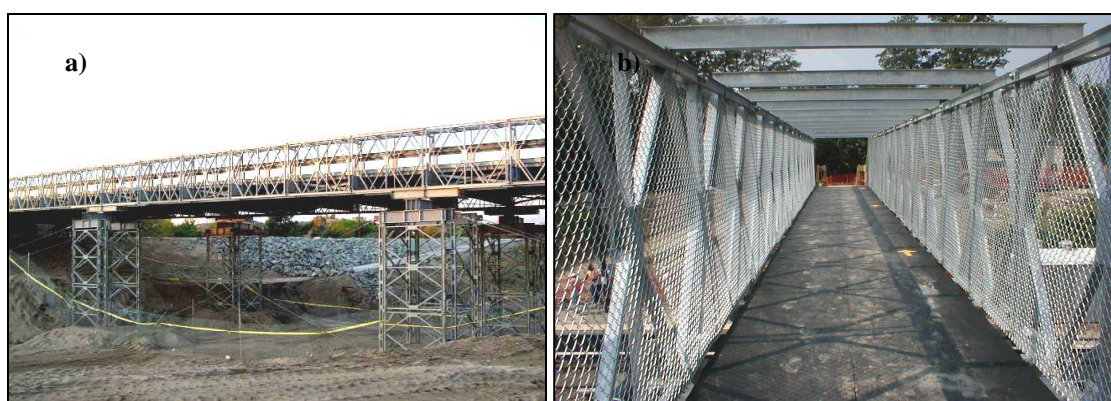
Rys. 17. Most składany Acrow 700XS: a) widok ogólny mostu na podporach pośrednich, b) widok ogólny kładki dla pieszych
