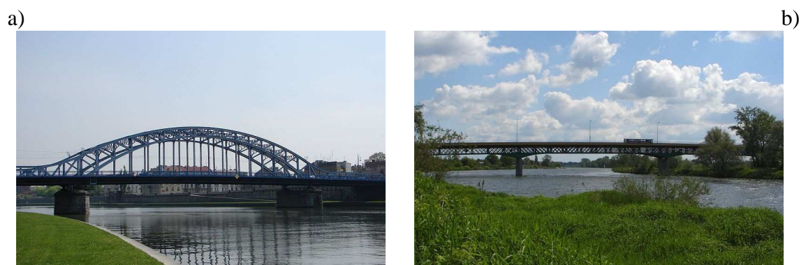
Rys. 3. Przykłady cywilnych obiektów mostowych wykorzystywanych w sytuacjach kryzysowych, jak i w działaniach wojennych
