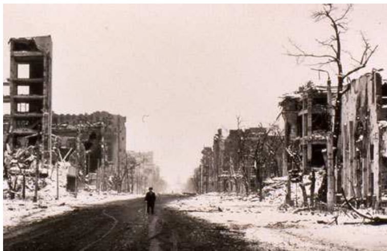
Rys. 7. Obraz zniszczeń w Groznym
