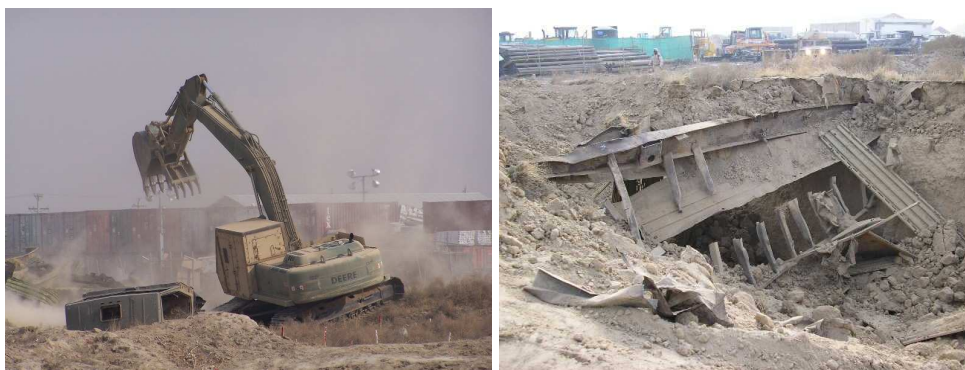
Fot. 7. Wykorzystanie koparki „HYEX” do rozbiórki schronów
