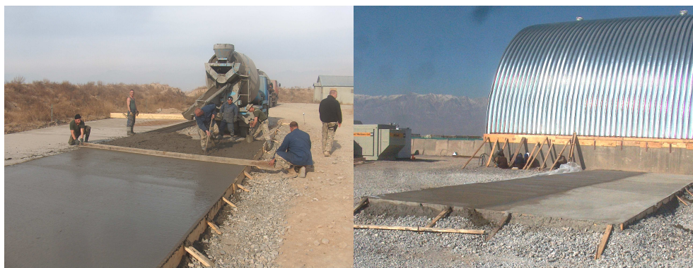
Fot. 10. Budowa nawierzchni z betonu cementowego pod urządzenia logistyczne
