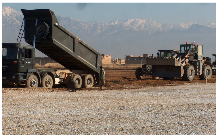
Fot. 11. Budowa placów logistycznych
