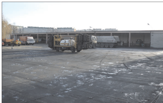
Fot. 2. Nawierzchnia placu parkingowego z płyt betonowych przed przykryciem warstwą z mieszanki SMA związanej asfaltem modyfikowanym gumą (fot. H. Koba)
