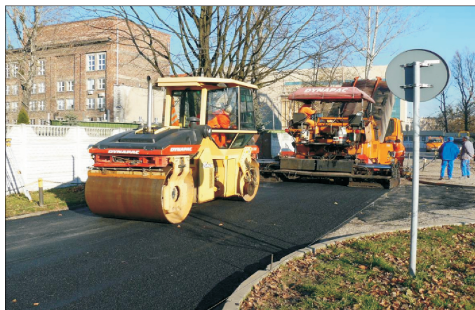
Fot. 3. Wbudowywanie warstwy z mieszanki SMA związanej asfaltem modyfikowanym gumą na placu parkingowym Politechniki Wrocławskiej (fot. H. Koba)
