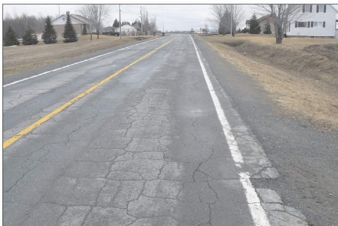
Fot. 5. Nawierzchnia drogi lokalnej przed remontem (Victoriaville) (fot. H. Koba)
