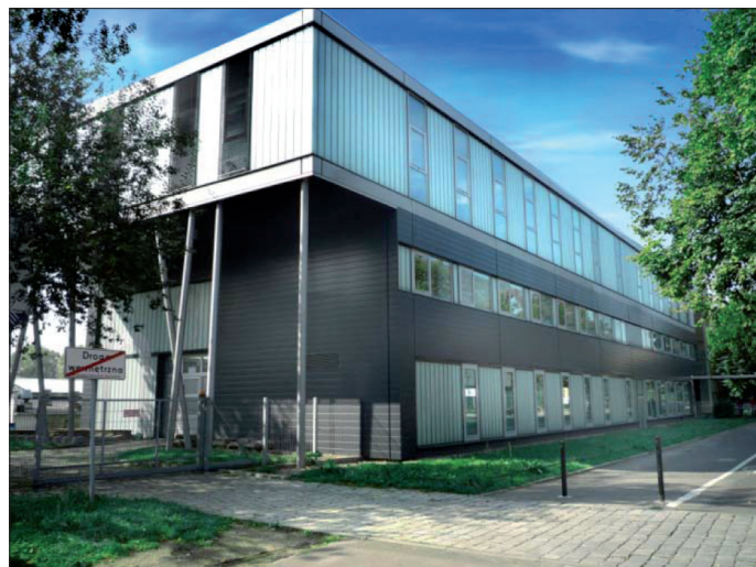
Fot. 3. Budynek Instytutu Inżynierii Lądowej. Siedziba Katedry Dróg i Lotnisk
