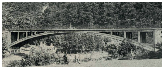
Rys. 7. Most na rz. Bormida w m. Isoletta, rozpiętość 50 m, Włochy, LBA-RTE 1908 , str. 107
