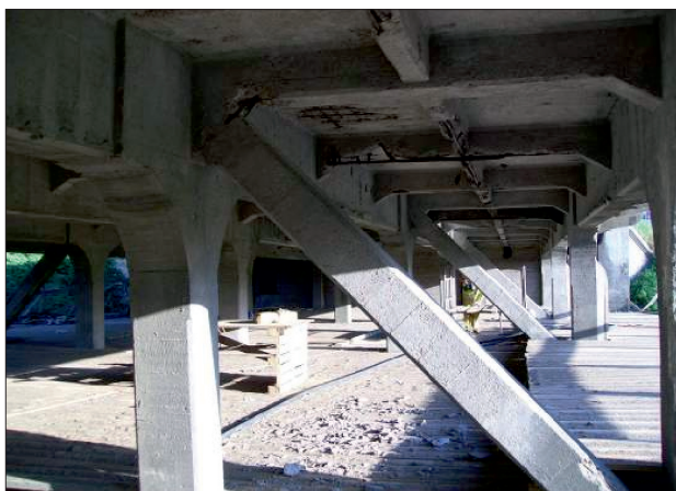
Rys. 2. Węzły sztywne pomiędzy płytą ortotropową a filarami mostu z 1909 r. w Lublinie; zdjęcie z 2011 r., w trakcie prac remontowych
