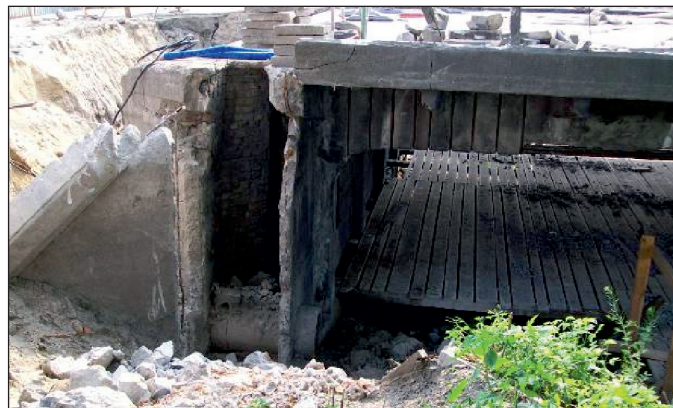
Rys. 11. Odstonięta konstrukcja przyczółków mostu Hennebique'a w Lublinie
