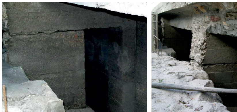
Rys. 12–13. Zdjęcia przegubu przesuwnego, zastosowanego ze względu na efekty termiczne
