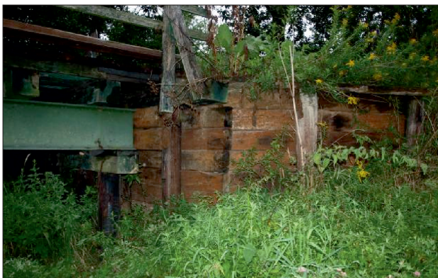
Rys. 15. Most drewniany w miejscowości Marcetki
