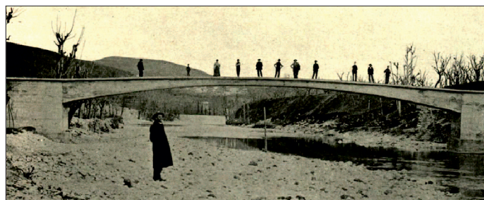
Rys. 6. Most na rz. Astico w m. Calvene, rozpiętość 34 m, Włochy, LBA-RTE 1908 , str. 105
