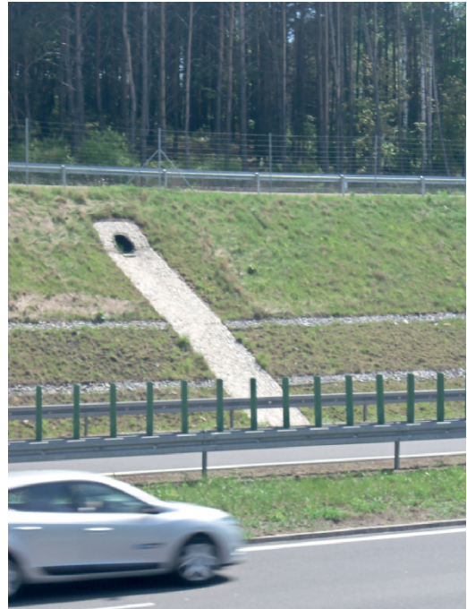
Fot. 4. Odpływ powierzchniowy umocniony narzutem kamiennym (fot. M. Głazewski)
