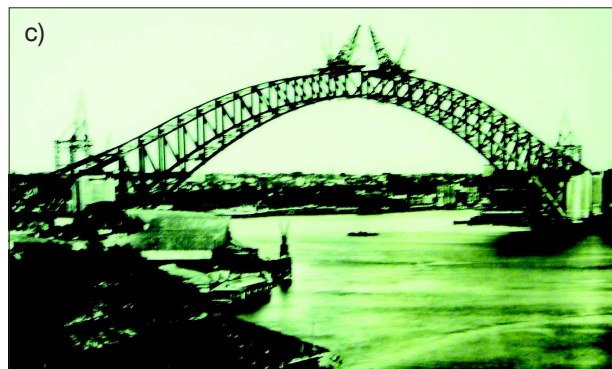
Fot. 1. Etapy montowania łuku – zdjęcia plansz wystawionych w muzeum mostu: a) utwierdzenie łuku na czas budowy liniami kotwionymi w tunelach, b) stan montażu na początku 1930 r., c) zwiarcie łuku w sierpniu 1930 r.
