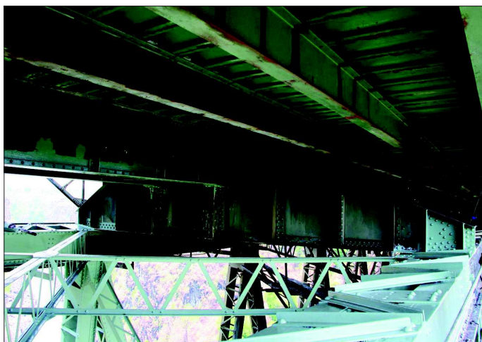
Fot. 4. Stalowe elementy konstrukcji mostu
