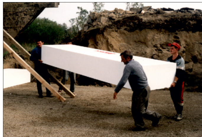
Fot. 1. Układanie bloków styropianu za przyczółkiem (Fot. K. Grzegorzewicz)
