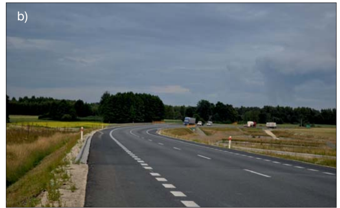
Fot. 1. Obwodnica Mszczonowa (droga krajowa nr 50): a) widok ogólny, b) początek odcinka testowego z nawierzchni z asfaltu porowatego PA11
