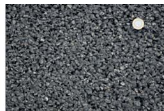
BBTM8 (odc. 070, km 0+950)
