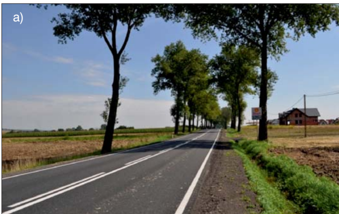
Fot. 2. Droga wojewódzka nr 780: a) odcinek o nawierzchni z BBTM8, b) odcinek o nawierzchni z asfaltu porowatego PA8
