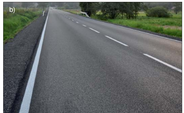
Fot. 2. Droga wojewódzka nr 780: a) odcinek o nawierzchni z BBTM8, b) odcinek o nawierzchni z asfaltu porowatego PA8
