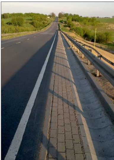
Fot. 3. Odcinek drogi krajowej nr 63 po wykonaniu prac zabezpieczających skarpę przed erozją (fot. Z. Szypcio, K. Dołyżk)
