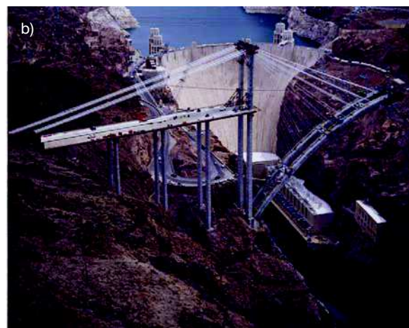
Fot. 12. Pierwsze fragmenty przęsła głównego: a) po stronie stanu Arizona, b) po stronie stanu Nevada
