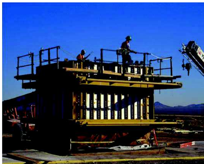
Fot. 11. Forma do budowy przęsła łukowego
