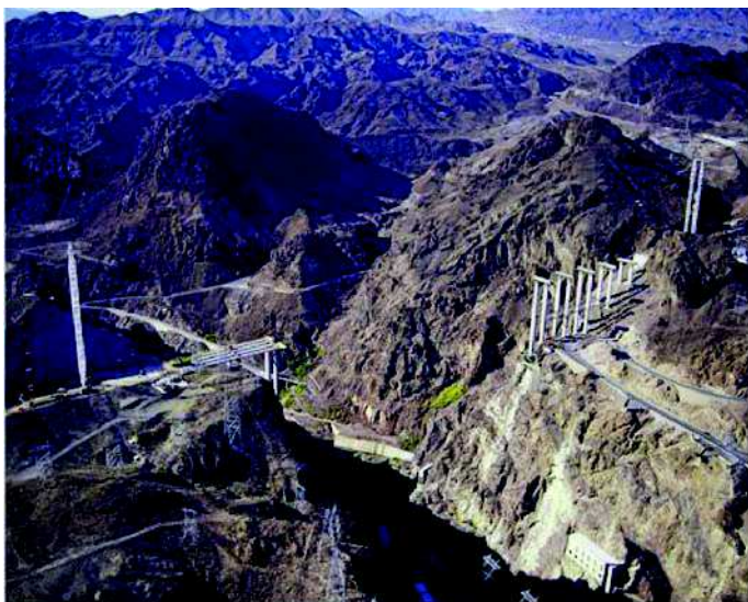
Fot. 10. Budowa pierwszych przęseł mostu
