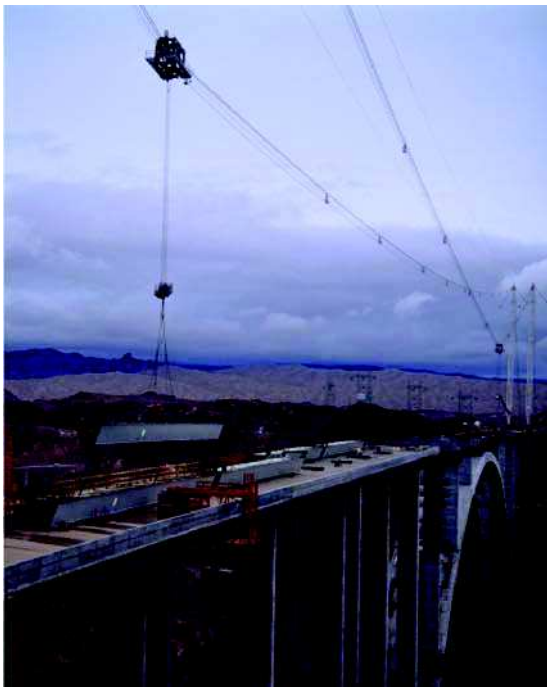
Fot. 16. Montaż stalowych elementów skrzynkowych pomostu
