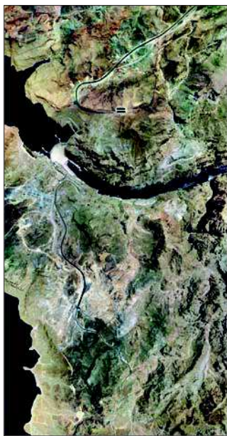
Fot. 3. Widok z lotu ptaka przed rozpoczęciem budowy; istniejąca droga w stanie Arizona widoczna w górnej części zdjęcia
