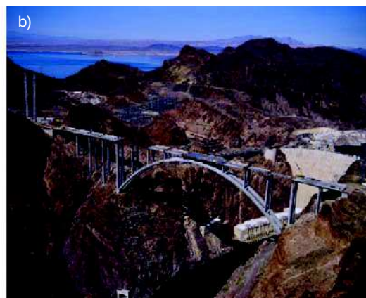
Fot. 14. Kolejne fazy budowy głównego przęsła: a) domknięcie łuku, b) budowa pomostu
