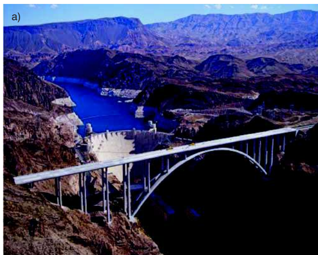
Fot. 18 a,b) Most i droga przygotowane do ceremonii otwarcia
