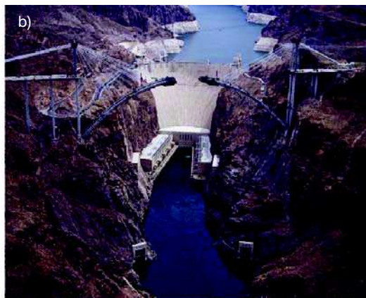
Fot. 13. Postęp w budowie łuku: a) faza początkowa, b) faza końcowa
