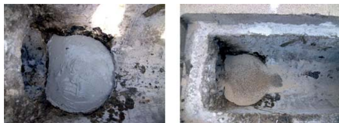
Fot. 10–11. Uzupełnienie dna kanału warstwą zaprawy PCC. Uzupełnienie dna kanału warstwą żywicy epoksydowej z piaskiem
