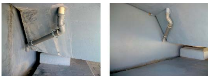
Fot.12–13. Prace końcowe przy wyprowadzeniu wylotu sączka rurą PCV do kanału w półce podłóżyskowej (30.08.2011 r.)
