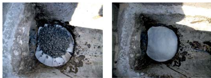
Fot. 8–9. Ułożenie na sitku warstwy gysu. Przekrycie gysu kolejną warstwą geowłókniny
