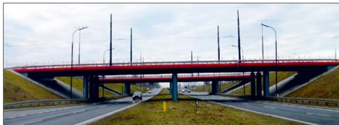
Fot. 1. Widok wiaduktu od wschodu
