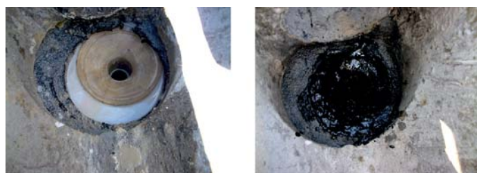
Fot. 4–5. Osadzony sączek, wypełnienie zaprawą PCC przestrzeni pod kołnierzem. Posmarowany masą bitumiczną kołnierz sączka
