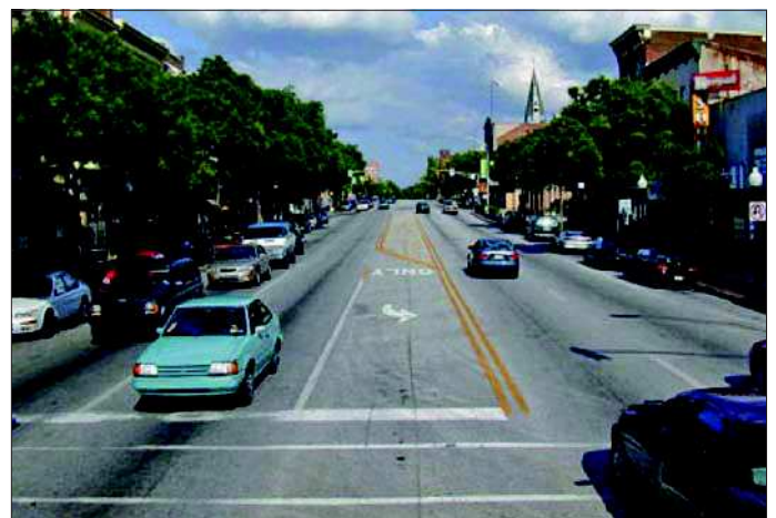
Fot. 1. a) Przed przebudową: pięć pasów ruchu na Main Street w Potsttown, stan Pennsylvania [2]
