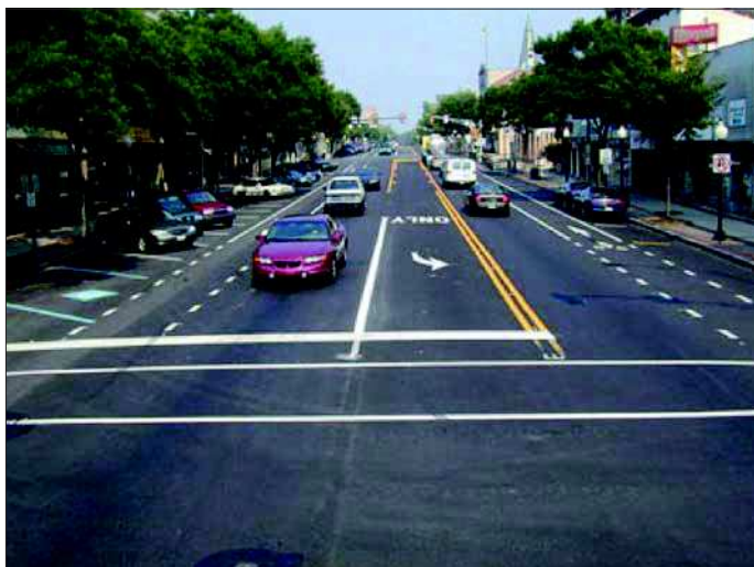
Fot. 1. b) Po przebudowie: zmniejszenie liczby pasów ruchu na Main Street pozwoliło na dodanie wydzielonych ścieżek rowerowych i zwiększenie miejsc parkingowych po lewej stronie ulicy (parkowanie tyłem pod kątem zamiast parkowania równoległego), zachęcające potencjalnych klientów do korzystania z lokalnych usług [2]
