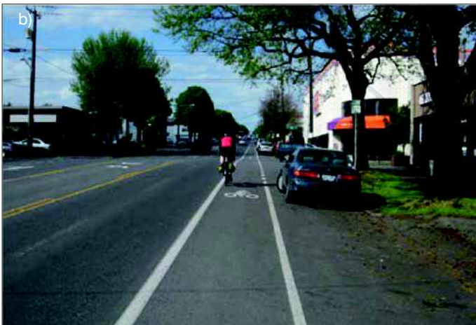
Fot. 3. a) Droga na przedmieściach Seattle, Stone Way North, w stanie Waszyngton przed przebudową. Zły stan nawierzchni, brak ścieżek rowerowych, brak oznakowanych przejść dla pieszych; b) Ta sama droga po przebudowie; nowa nawierzchnia, jeden pas ruchu w każdym kierunku, pas środkowy dla ruchu lewoskrętnego, ścieżka rowerowa
