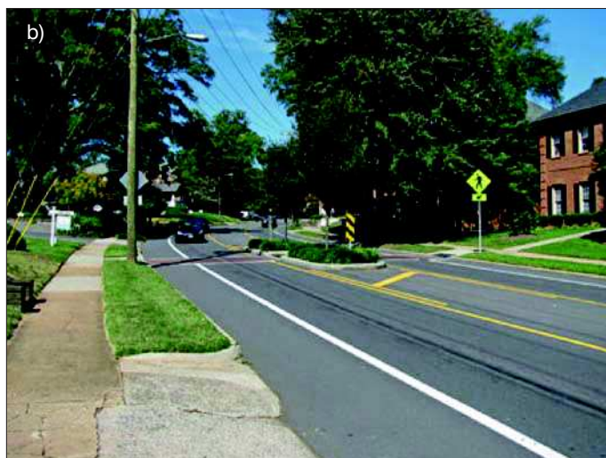
Fot. 2. a) Droga w czasie przebudowy w Charlotte, stan North Carolina; b) Ta sama droga po przebudowie; poprzednia 4-pasowa jezdnia zredukowana do 2 pasów ze ścieżkami rowerowymi po obu stronach oraz azylem w pasie środkowym ułatwiającym przejście pieszym [3]
