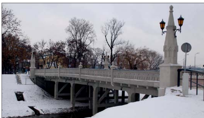
Fot. 1. Widok mostu od górnej wody rzeki Bystrzycy zbudowanego przez inż. Mariana Lutosławskiego w 1909 r., a odremontowanego w latach 2011/2012
