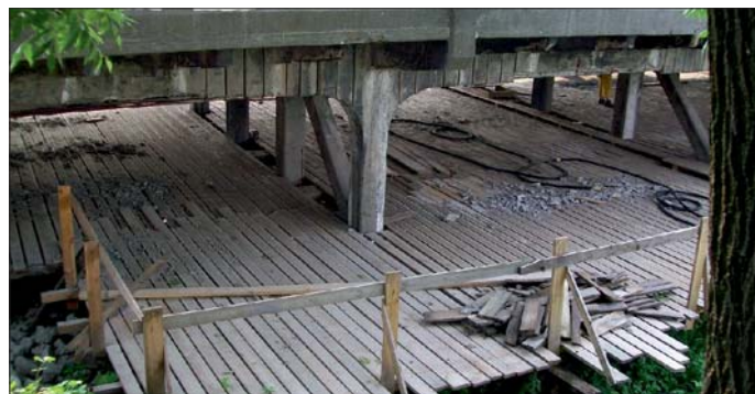
Fot. 10. Bruzdowanie powierzchni bocznych dźwigarów
