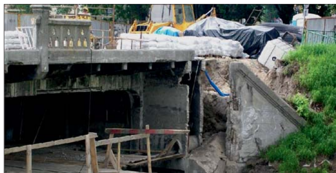
Fot. 5. Widok konstrukcji przyczółka od strony ul. Zamojskiej podczas remontu
