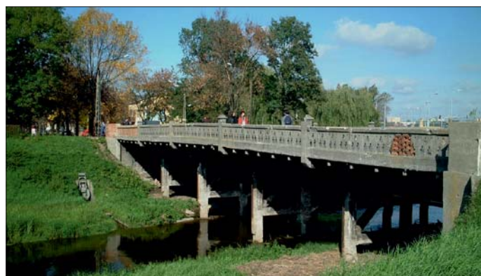
Fot. 2. Widok mostu przed remontem (2002 r.)
