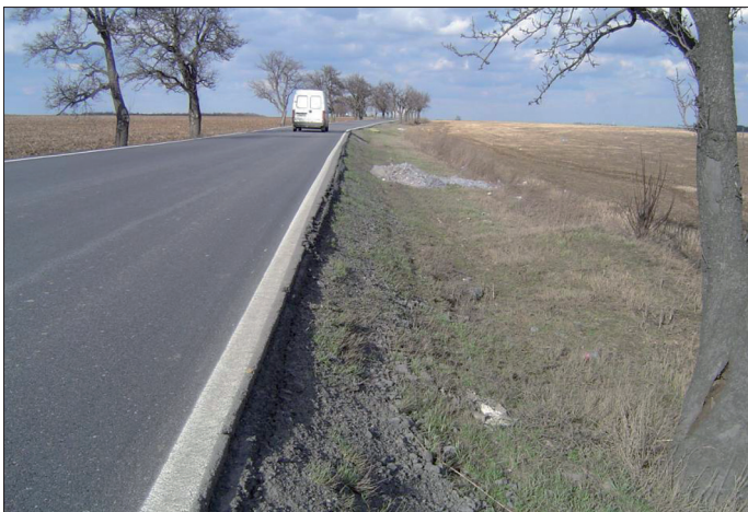
Fot. 6. Brak pobocza wzdłuż ruchliwej drogi na przedmieściach Pragi
