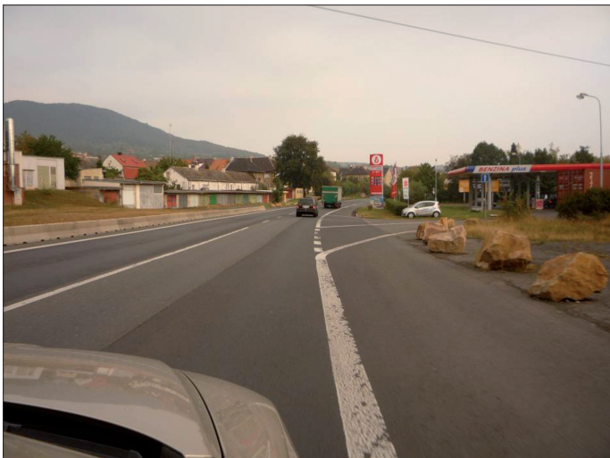
Fot. 5. Droga pierwszej klasy (I/30) o znaczeniu drogi europejskiej, na której glazy zastępują słupki prowadzące
