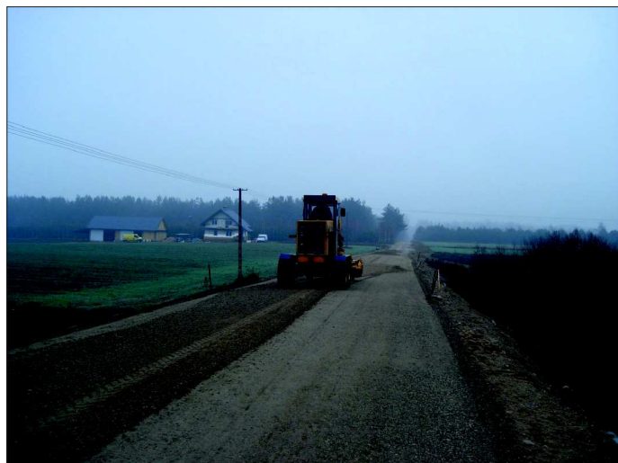
Fot. 11. Proces układania i zagęszczania warstwy dolnej podbudowy z kruszywa łamanego
