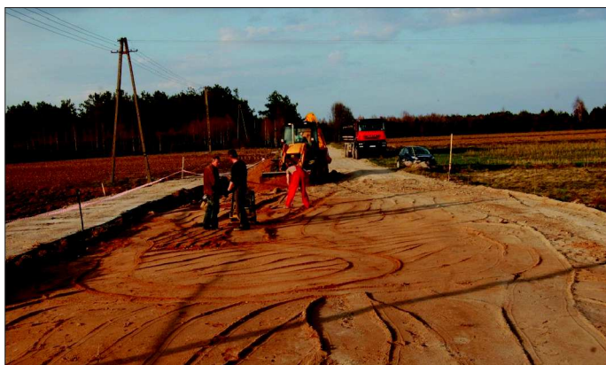
Fot. 4. Przygotowanie podłoża pod nasyp drogowy
