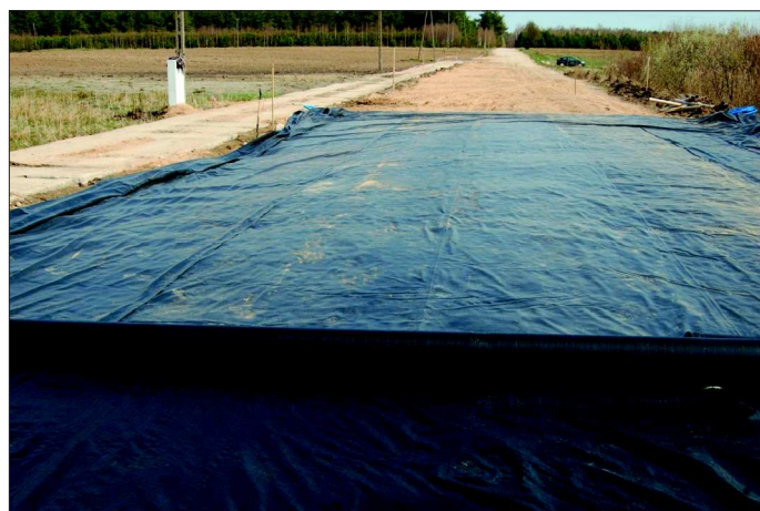
Fot. 7. Rozkładanie geomembrany i geowłókniny
