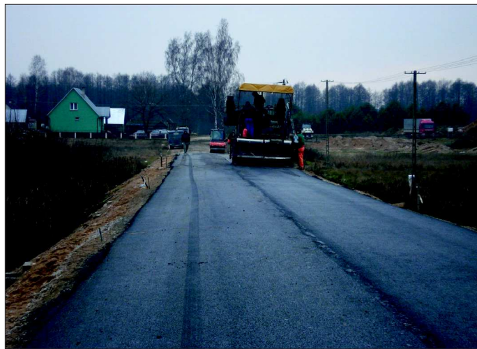
Fot. 13. Rozkładanie warstwy górnej podbudowy z mieszanki AC 16 P
