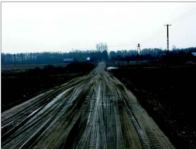
Fot. 3. Droga gminna w Czuprynowie przed wykonaniem nasypu
