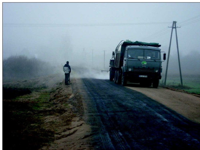
Fot. 12. Skropienie podbudowy z kruszywa łamanego emulsją asfaltową
