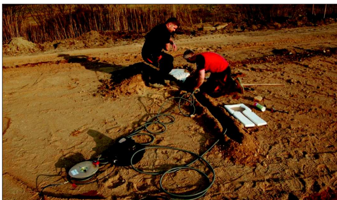
Fot. 5. Instalacja czujników parcia pod nasypem
