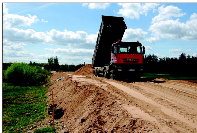
Fot. 10. Końcowy etap formowania górnej części nasypu
