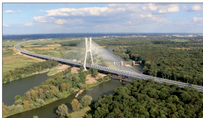
Fot. 3. Gotowy most Rędziański w ciągu Autostradowej Obwodnicy Wrocławia (fot. W. Kluczewski)
