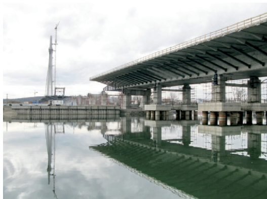
Fot. 2. Nasuwanie podłużne przęseł bocznych i montaż wspornikowy przęśla głównego [2]
