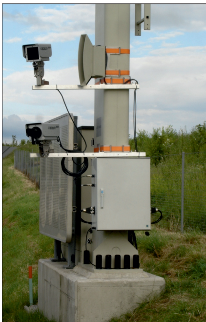
Fot. 6. Tymczasowe urządzenie kontrolne zainstalowane na wsporniku bramownicy
