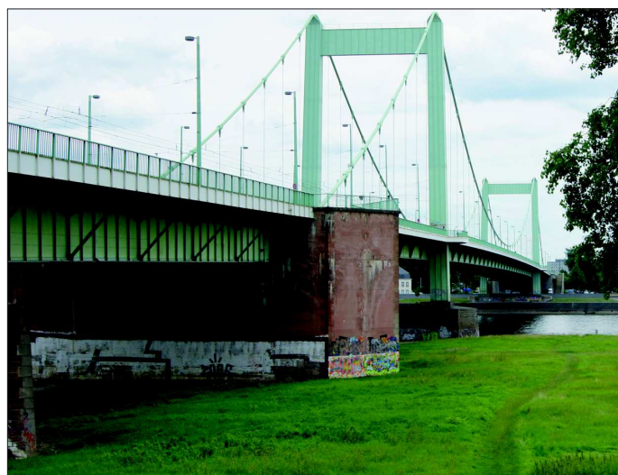
Fot. 5. Mülheimerbrücke – widok z terenów zalewowych lewego brzegu
