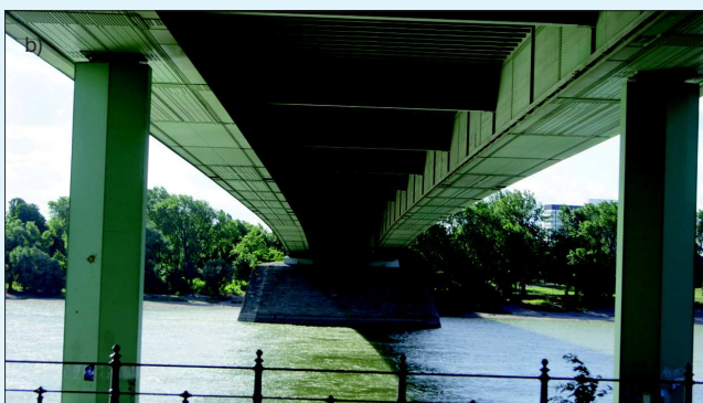
Fot. 8. Zoobrücke: a) widok z lewego brzegu Renu, b) uźebrowanie pomostu
