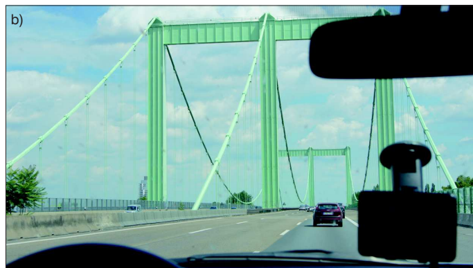
Fot. 6. Rodenkirchenerbrücke: a) widok z wysokiego budynku na lewym brzegu Renu, b) stalowe pylony ramowe dawnej i nowej części mostu
