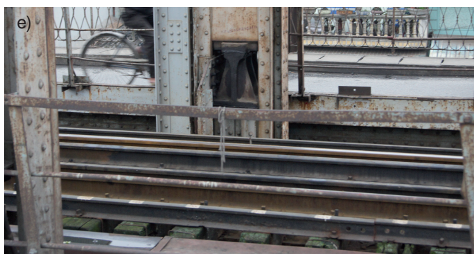
Fot. 2. Most Long Bien w marcu 2011 r.: a) prześła nad wyspą i starorzeczem przy centrum Hanoi położonym na prawym brzegu, b) prześła nad głównym korytem Rzeki Czerwonej, c) wjazd na most z lewego brzegu d) tabliczka upamiętniająca wykonawców mostu, e) łożysko pod skrajnym słupkiem prześły zawieszony na wsporniku, f) nieczynne torowisko mostu
