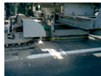
Fot. 3. Nacinanie nawierzchni (fot. NIPPO CORPORATION)
