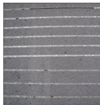
Fot. 2. Rowki w nawierzchni (fot. NIPPO CORPORATION)
