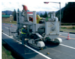
Fot. 3. Nacinanie nawierzchni (fot. NIPPO CORPORATION)
