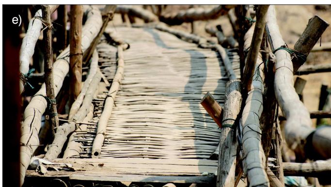
Fot. 1. Most tymczasowy przez Nam Khan z drewna bambusowego: a) widok mostu ze skarpy rzecznej, b) widok z boku, c) połączenia elementów mostu sznurem, d) podpory mostu obciążone workami z piaskiem, e) pomost pleciony z bambusowych różeg, f) widok ogólny mostu
