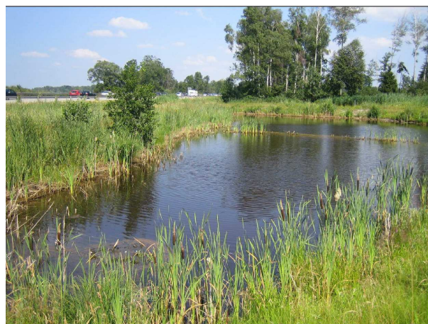
Fot. 4. Przykład zbiornika retencyjno-infiltracyjnego [2]
