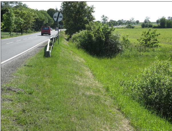
Fot. 1. Przykład zastosowania powierzchni trawiastej przy drodze
