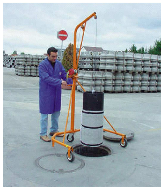
Fot. 7. Wymiana wkładu koalescencyjnego
