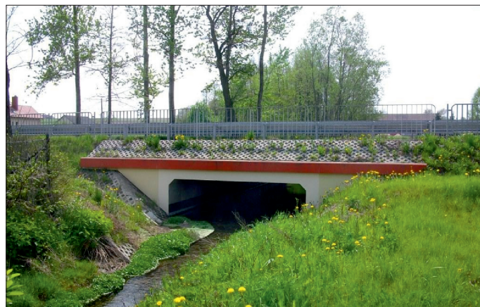
Fot. 6. Przepust nad rzeką Krynicą w miejscowości Fajstawice
