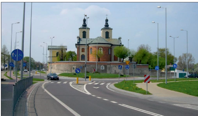
Fot. 3. Rondo na skrzyżowaniu drogi nr 17 z ul. Lubelską w miejscowości Piaski
