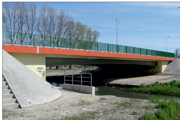
Fot. 4. Nowy most przez rzekę Gielczew w miejscowości Piaski
