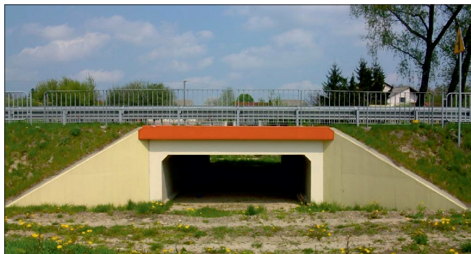
Fot. 5. Przepust nad suchym ciekim w miejscowości Ignasin
