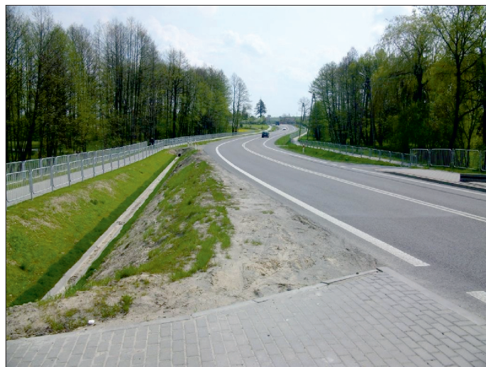
Fot. 1. Poziome łuki po dostosowaniu do wyższych parametrów projektowych
