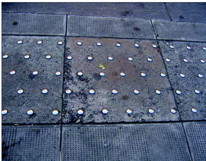
Fot. 13. Nawierzchnie ostrzegawcze z płyt betonowych z guzkami metalowymi (Genewa/Szwajcaria)
