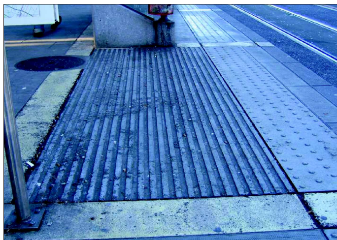
Fot. 7. Miejsce oczekiwania osoby niepełnosprawnej wyróżnione nawierzchnią w formie płyt z podłużnymi wyżłobieniami (Genewa/Szwajcaria)
