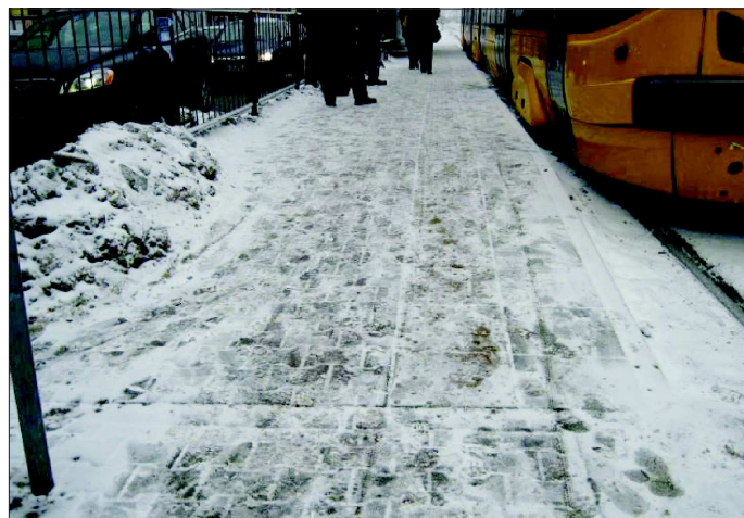
Fot. 11. Ośnieżona pochylnia przystanku tramwajowego (Warszawa/Polska)
