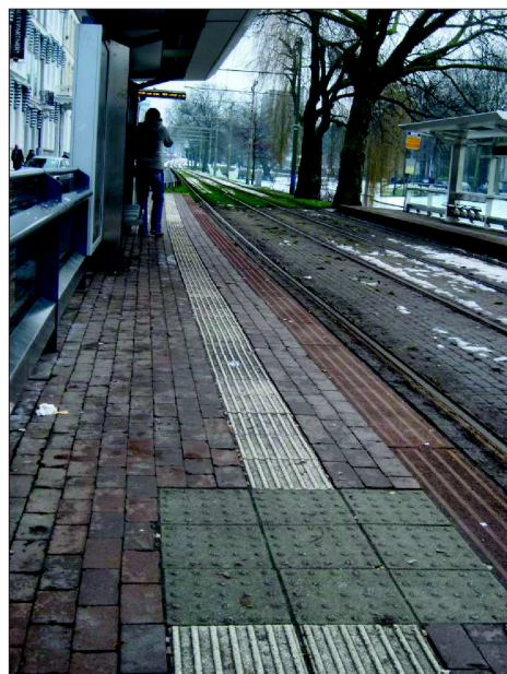
Fot. 6. Miejsce oczekiwania osoby niepełnosprawnej wyróżnione nawierzchnią płyt z guzkami (Rotterdam/Holandia)
