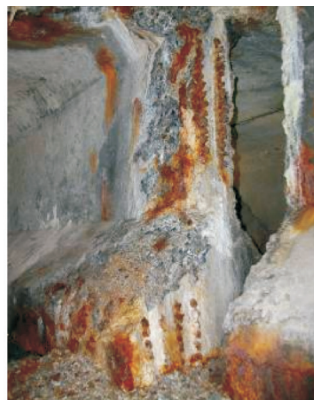
Fot. 9. Intensywna korozja betonu dźwigarów głównych na ich końcach oraz widoczna korozja stali sprężającej w miejscu ubytków betonu [6]
