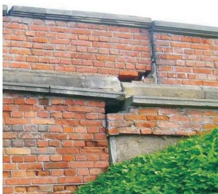
Fot. 3. Uszkodzenia muru: a) osiadanie względem skrzydła, b) pęknięcie w miejscu styku ze skrzydłem [7]
