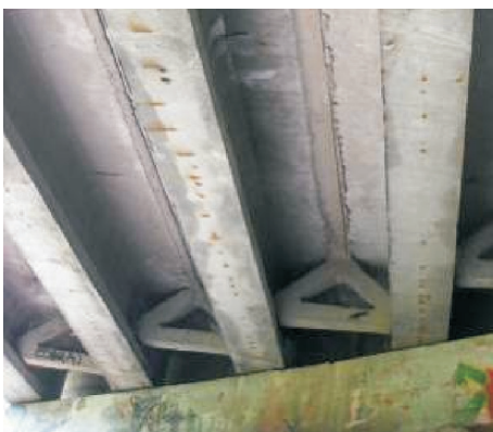
Fot. 10. Widoczna korozja strzemion na spodach dźwigarów prefabrykowanych [6]
