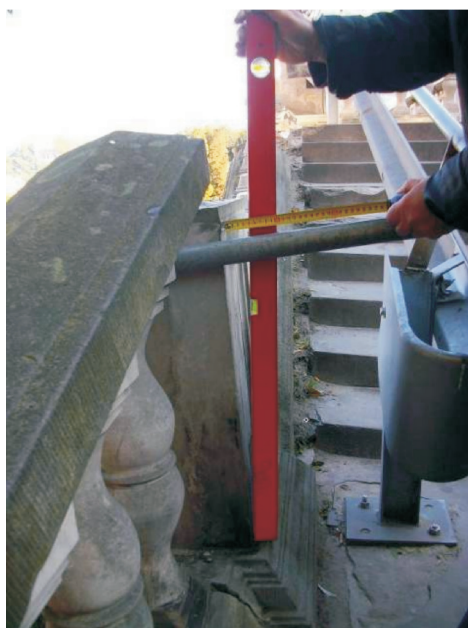
Fot. 6. Odchylenie balustrady schodów od pionu o 5 cm/70 cm. Tymczasowa ochrona przed wejściem pieszych nie gwarantuje dalszego niszczenia kolejnych elementów balustrady i schodów [7]
