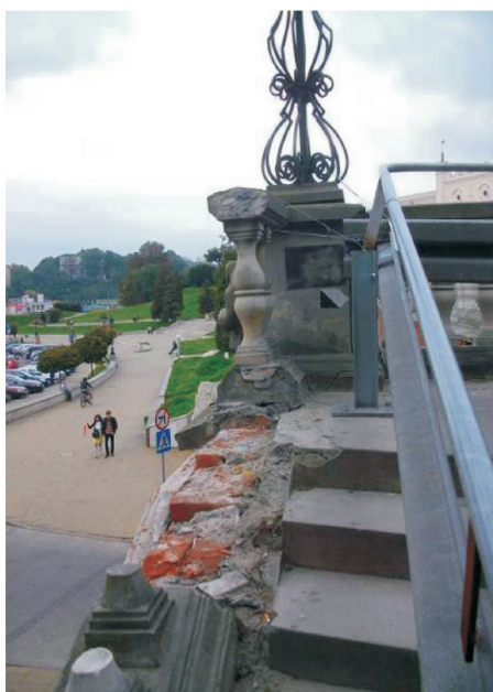
Fot. 6. Odchylenie balustrady schodów od pionu o 5 cm/70 cm. Tymczasowa ochrona przed wejściem pieszych nie gwarantuje dalszego niszczenia kolejnych elementów balustrady i schodów [7]
