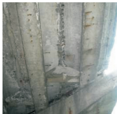
Fot. 10. Widoczna korozja strzemion na spodach dźwigarów prefabrykowanych [6]
