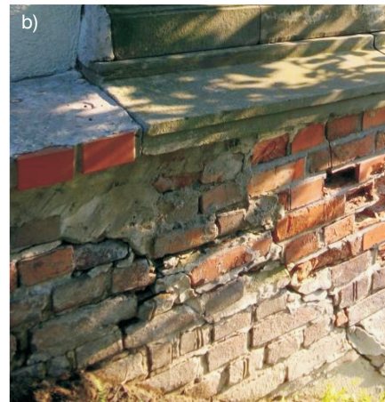
Fot. 3. Uszkodzenia muru: a) osiadanie względem skrzydła, b) pęknięcie w miejscu styku ze skrzydłem [7]
