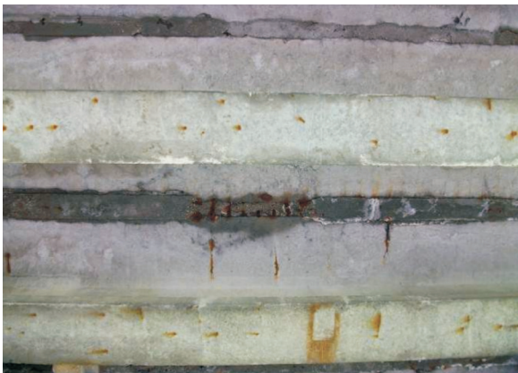
Fot. 7. Skutki nieszczelnej izolacji [6]
