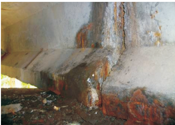
Fot. 9. Intensywna korozja betonu dźwigarów głównych na ich końcach oraz widoczna korozja stali sprężającej w miejscu ubytków betonu [6]
