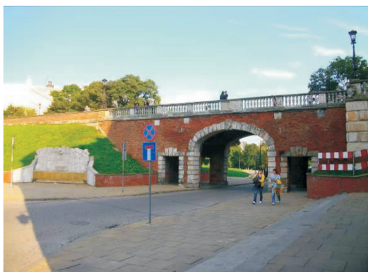
Fot. 1. Wiadukt nad ulicą Podwale [7]
