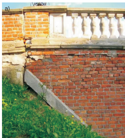
Fot. 4. Uszkodzenia skrzydeł: wykruszenia cegieł, odspajanie od muru, osiadanie nasypu; a) widok po stronie Placu Zamkowego, b) widok po stronie Podwala [7]
