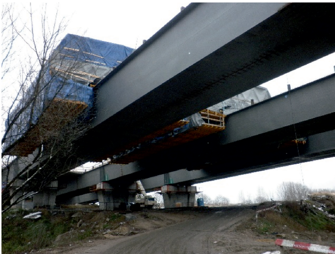
Fot. 33. Wózki do betonowania płyt pomostu w części prawobrzeżnej mostu
