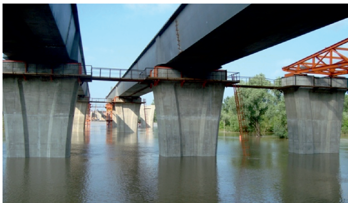
Fot. 35. Stan podpór w czasie przechodzenia fali powodziowej w 2010 r.
