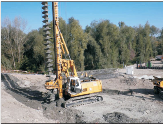
Fot. 4. Wykonywanie pali wierconych świdrem ciągłym CFA
