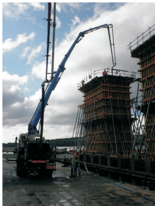
Fot. 11. Betonowanie podpory nurtowej P50
