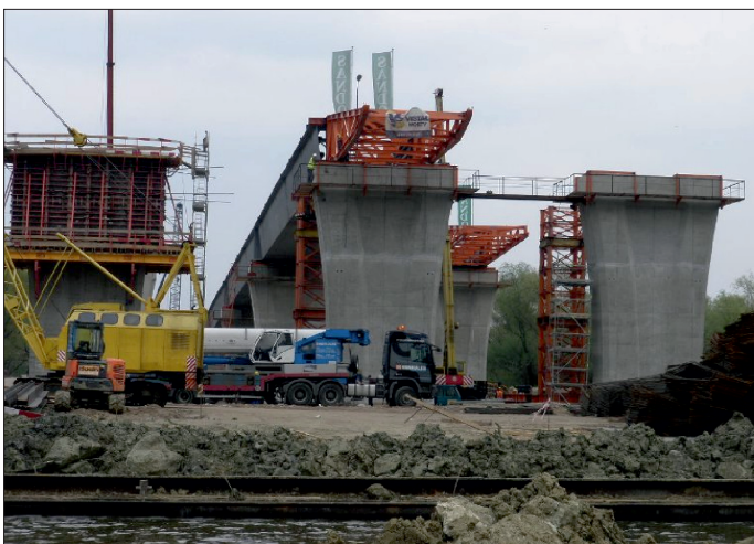
Fot. 21. Stan nasuwania konstrukcji po dojeździe do nurtu Wisły
