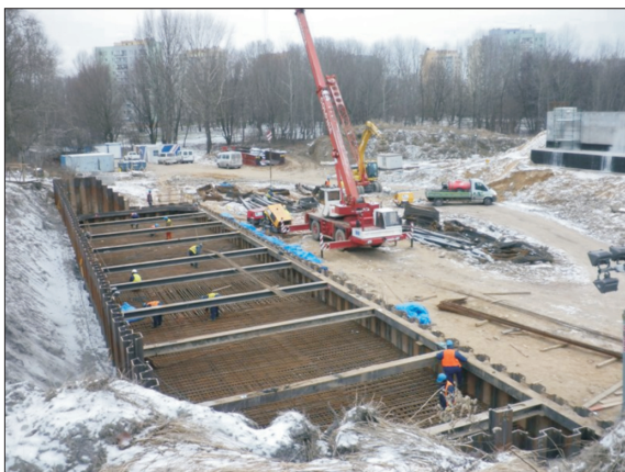
Fot. 6. Wykonywanie stopy fundamentowej podpory w grodzicach stalowych
