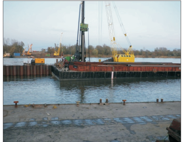
Fot. 7. Wykonywanie fundamentu podpory nurtowej
