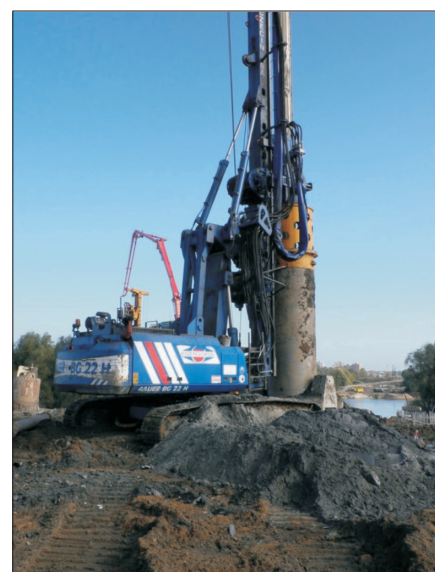
Fot. 3. Wykonywanie pali wierconych w rurze obsadowej
