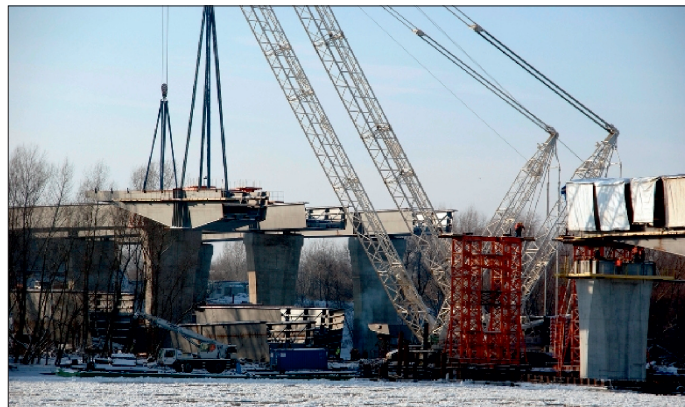
Fot. 23. Dźwiganie elementu konstrukcji przy użyciu żurawia po stronie lewo-brzeżnej
