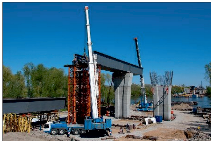
Fot. 24. Ustawianie pierwszego elementu konstrukcji M2 po stronie lewo-brzeżnej
