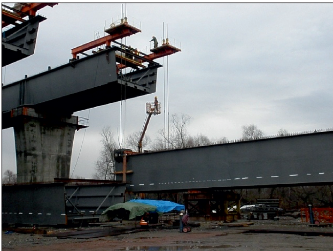
Fot. 25. Przygotowanie do podciągania części konstrukcji mostu
