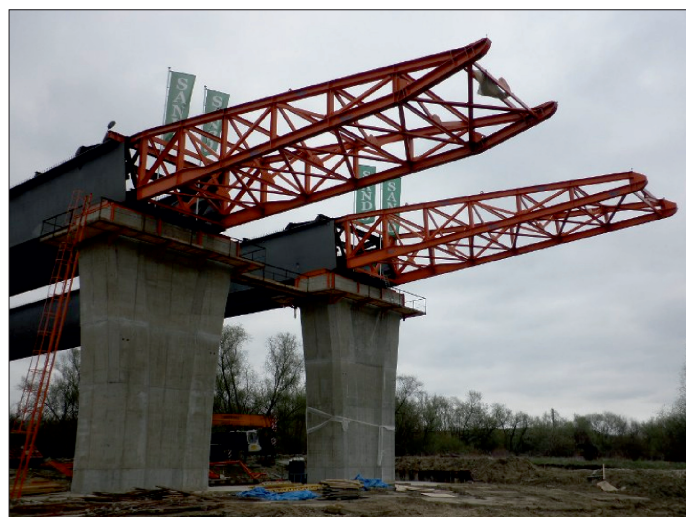
Fot. 18. Dziób montażowy po wjeździe na podporę P80
