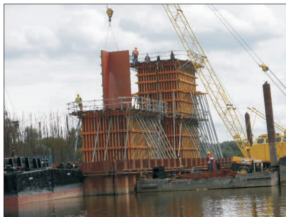
Fot. 14. Przygotowywanie deskowania do betonowania filarów podpory
