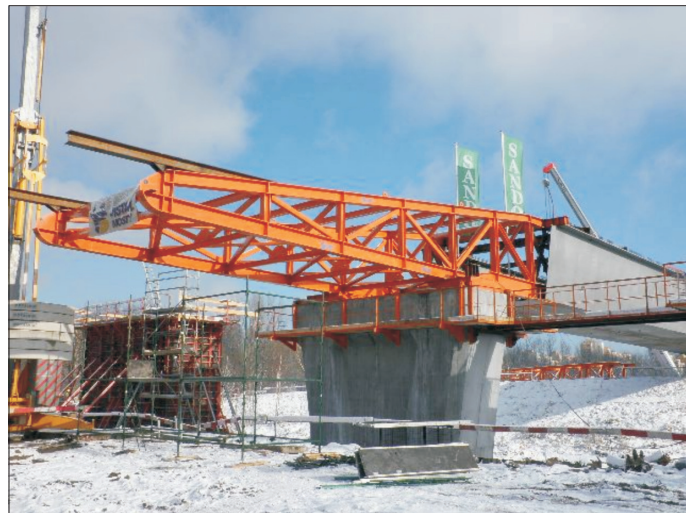
Fot. 17. Dziób montażowy po wjeździe na pierwszą podporę od przyczółka P110
