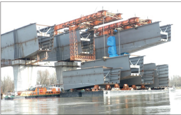
Fot. 28. Podciąganie elementu nitki M2 za pomocą lin do sprężania
