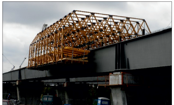
Fot. 31. Konstrukcja wózka do betonowania płyty pomostu
