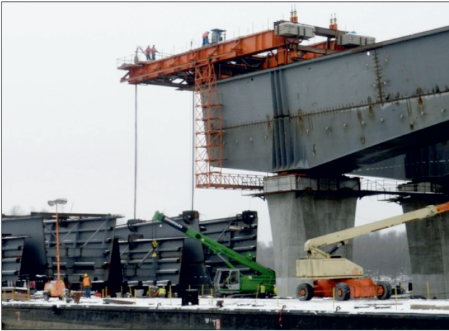
Fot. 27. Przygotowanie do podciągania pierwszego elementu za pomocą lin do sprężania
