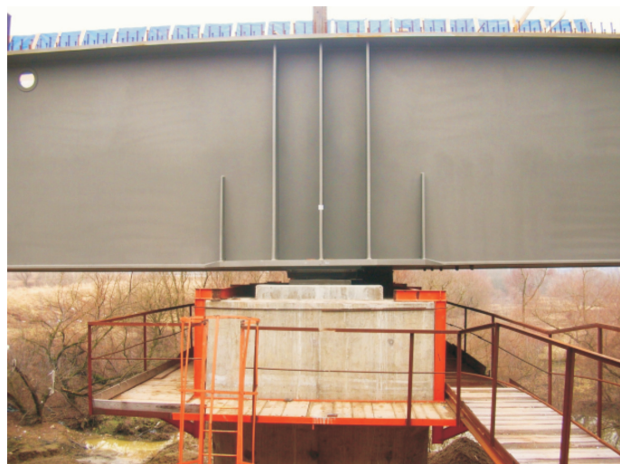
Fot. 2. Strefa podparcia konstrukcji stalowej na głowicy podpory P80
