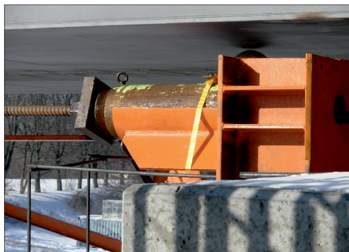
Fot. 19. Ustawienie naciągarki do nasuwania konstrukcji niosącej na ławie przyczółka
