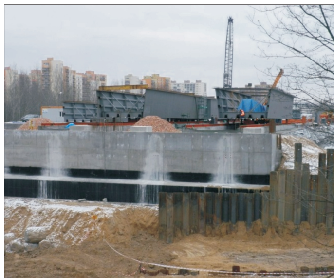
Fot. 16. Scalone elementy konstrukcji niosącej w oczekiwaniu na nasunięcie przy przyczółku P110
