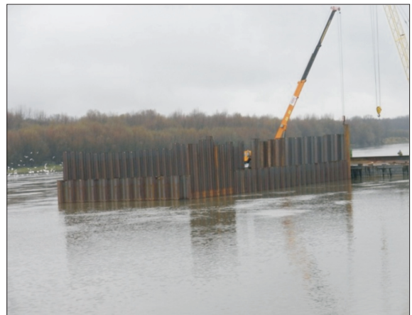
Fot. 8. Wykonywanie podpory nurtowej w grodzicach stalowych
