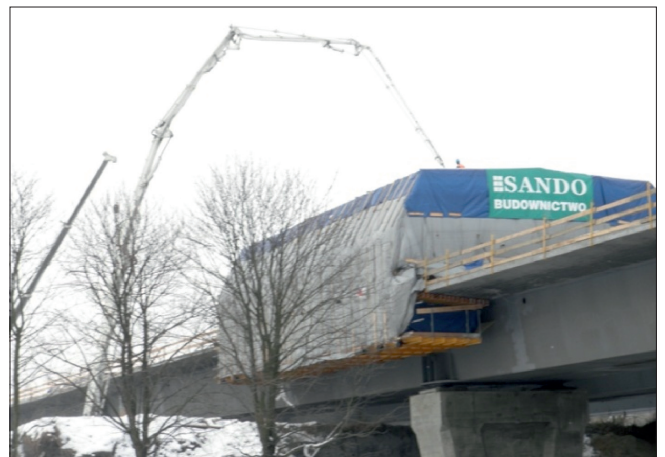
Fot. 32. Betonowanie płyty pomostu pod osłoną cieplą
