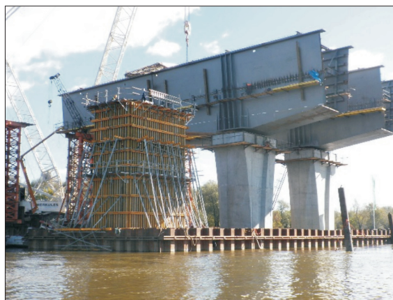
Fot. 13. Betonowanie trzeciego filara w podporze nurtowej P50; pierwsze segmenty konstrukcji niosącej na pozostałych filarach
