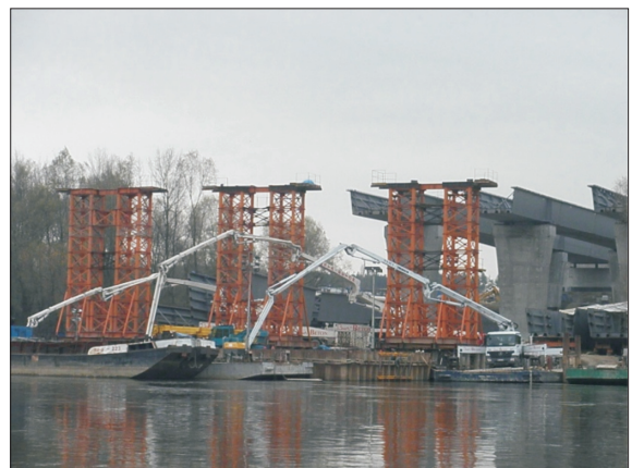
Fot. 9. Betonowanie podpory nurtowej z barek
