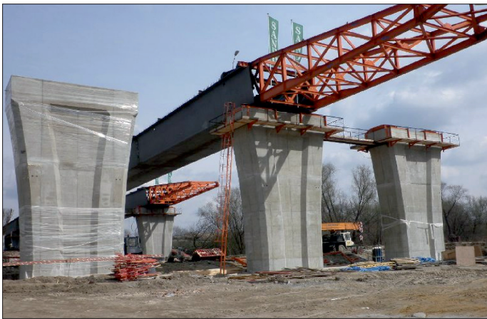
Fot. 20. Dziób montażowy konstrukcji niosącej nitki M2
