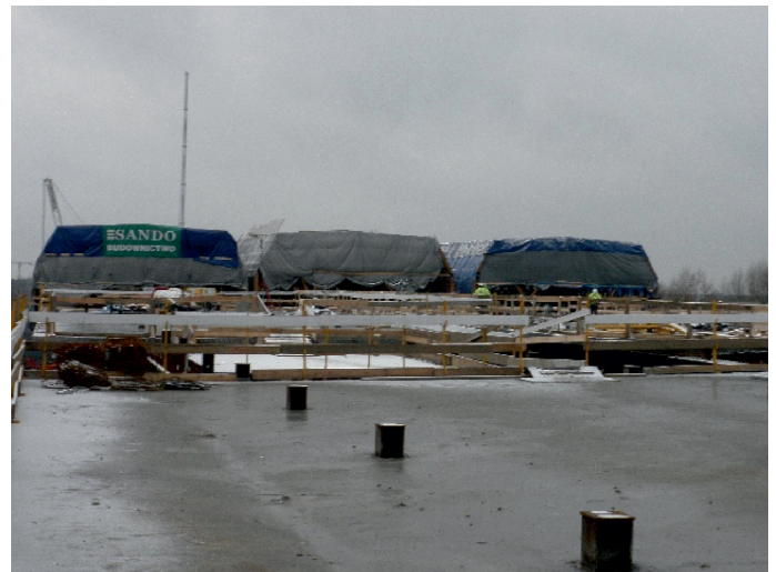
Fot. 34. Fragment gotowej płyty pomostu
