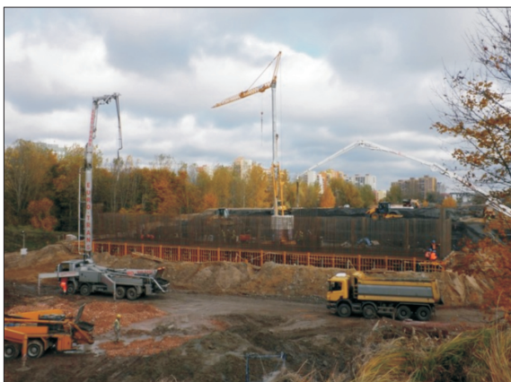
Fot. 5. Wykonywanie stopy fundamentowej podpory
