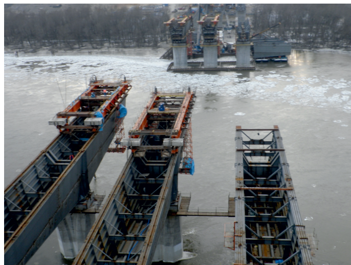
Fot. 37. Stan budowy w końcu lutego 2011 r. – widok na część nurtową w kierunku prawego brzegu
