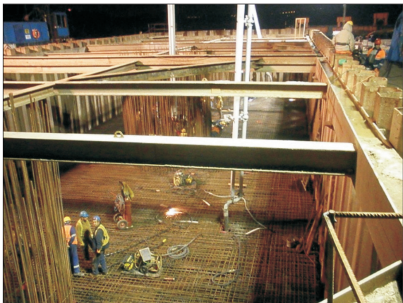
Fot. 10. Betonowanie stopy fundamentowej
