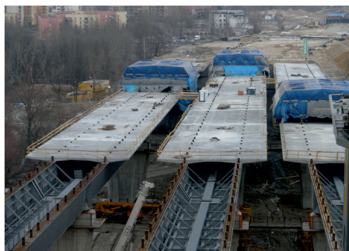
Fot. 38. Stan budowy w końcu lutego 2011 r. – widok w kierunku lewego brzegu
