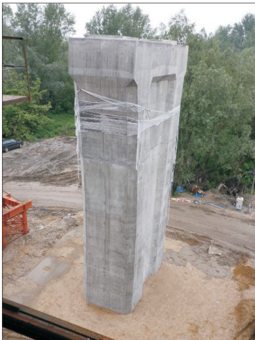
Fot. 15. Filar podpory po rozdeskowaniu
