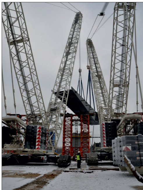
Fot. 22. Dźwiganie elementu konstrukcji przy użyciu dwóch żurawi
