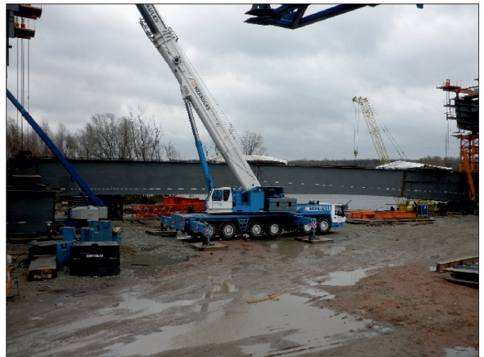
Fot. 26. Podciąganie na prętach segmentu środkowego przęsła
