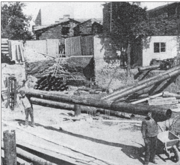
Rys. 47. Pale Mast – transport rur blaszanych
