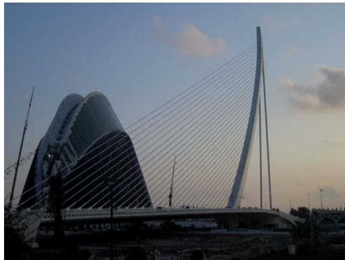
Fot. 6. Most podwieszony Serreria w Walencji na terenie Miasta Sztuki i Nauki
