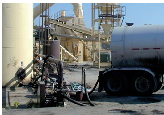
Fot. 5. Cysterna z emulsją Evoterm podłączona do instalacji pompowania asfaltu WMB [6]
