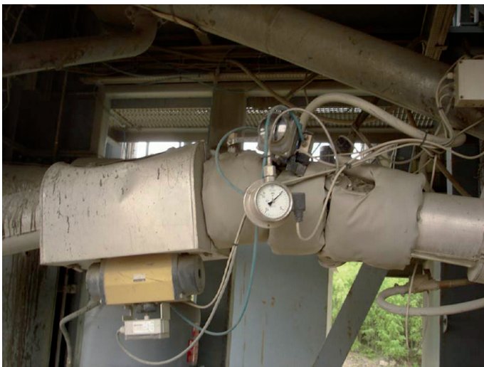
Fot. 2. Komora spienienia w powiększeniu [3]
