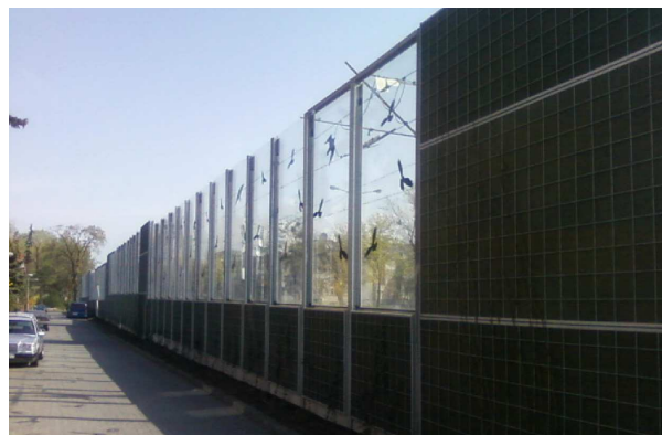
Fot. 8. Widok ekranu akustycznego wykonanego z kilku materiałów (fot. D. Bęben)
