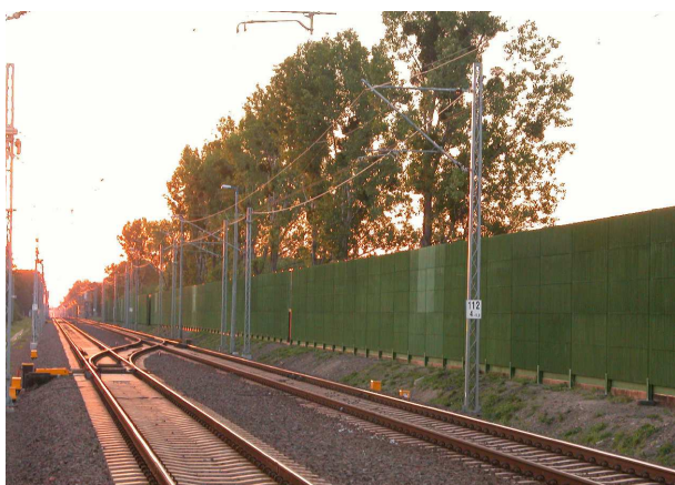
Fot. 6. Ekran akustyczny (firmy Techbud) o średniej wysokości przy linii kolejowej E-30 Opole–Wrocław (Dąbrowa Niemodlińska) [11]
