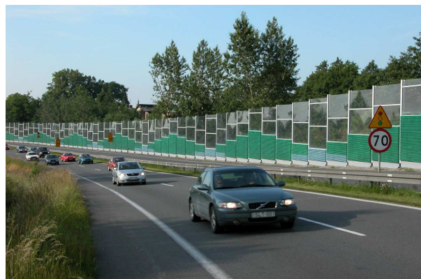
Fot. 1. Widok na ekran akustyczny (firmy Techbud) położony wzdłuż drogi szybkiego ruchu S-1 w Czechowicach-Dziedzicach [11]
