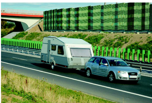
Fot. 4. Połączenie wału ziemnego z typowym ekranem akustycznym firmy Techbud z Krakowa, droga S-1 na odcinku Bielsko-Biała – Cieszyń [11]
