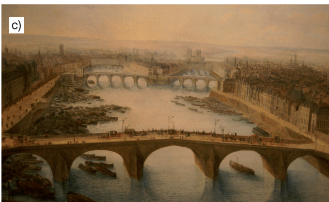
Fot. 3. Pont Neuf: a) projekt Pont Neuf o sklepieniach półkolistych – zatwierdzony w 1577 roku przez króla Henryka III, b) model pokazujący stan mostu po dziewięciu latach budowy, gdy zawieszono prace z powodu wojen religijnych; wznowiono je dopiero w 1599 r i ukończono w 1604, c) na drugim planie most w latach 1848–1855, gdy sklepienia spłaszczono na eliptyczne, obniżając niweletę, d) Pont Neuf i wyspa Cité w 1832 r. – Giuseppe Canella (1788–1847)
