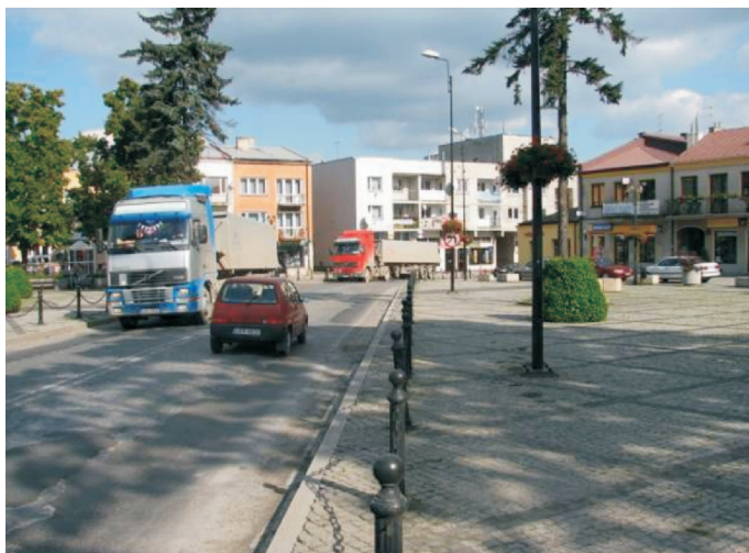
Fot. 1. Przebieg drogi krajowej nr 74 przez centrum miasta [2]
