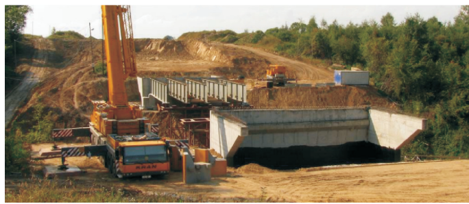
Fot. 5 Faza I montażu ustroju zespolonego – obiekt nr IV [4]
