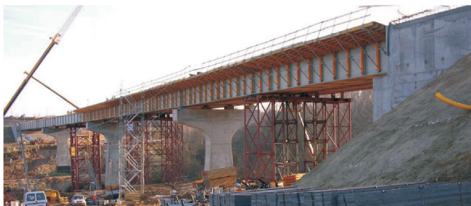
Fot. 4. Widok ogólny estakady – obiekt nr III [4]
