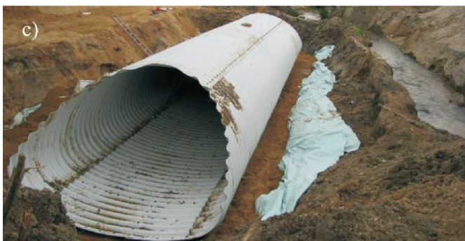
Fot. 7. Przepusty: a) konstrukcja stalowa MP200 – obiekt IX, b) konstrukcja MultiPlate w fazie montażu – obiekt X, c) na zdjęciu widoczne przełożenie rzeki – obiekt XI, d) obiekt XII – na zdjęciu widoczne umocnienie cieku płytami prefabrykowanymi [4].
