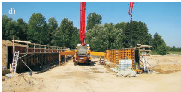
Fot. 2 Budowa przejazdów gospodarczych: a) żelbetowy wieńiec – obiekt I, b) montaż konstrukcji stalowej – obiekt nr II, c) na zdjęciu widoczne kotwy do mocowania ceowników – obiekt nr VI, d) betonowanie żelbetowych podpór – obiekt VIII [4]
