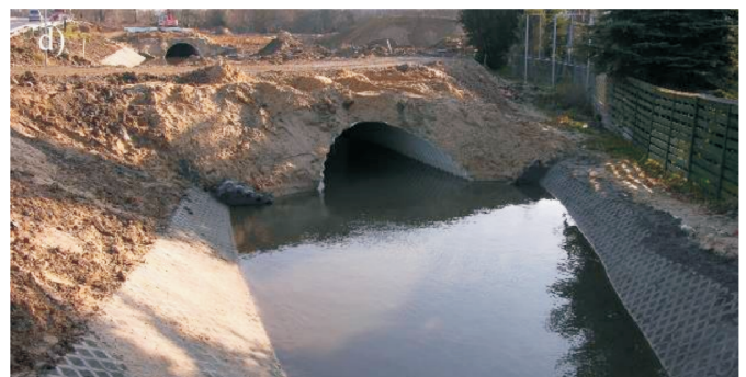
Fot. 7. Przepusty: a) konstrukcja stalowa MP200 – obiekt IX, b) konstrukcja MultiPlate w fazie montażu – obiekt X, c) na zdjęciu widoczne przełożenie rzeki – obiekt XI, d) obiekt XII – na zdjęciu widoczne umocnienie cieku płytami prefabrykowanymi [4].
