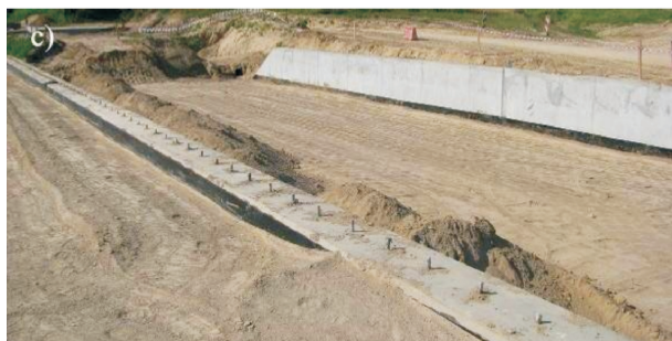
Fot. 2 Budowa przejazdów gospodarczych: a) żelbetowy wieńiec – obiekt I, b) montaż konstrukcji stalowej – obiekt nr II, c) na zdjęciu widoczne kotwy do mocowania ceowników – obiekt nr VI, d) betonowanie żelbetowych podpór – obiekt VIII [4]
