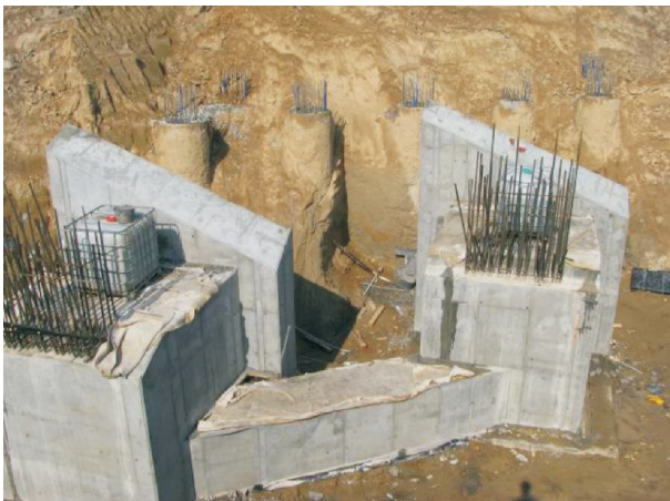
Fot. 6 Masywne, żelbetowe bloki podpór łuków – przed betonowaniem i po zdjęciu szalunku [4]
