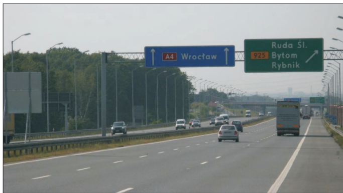
Fot. 2. Drogowskaz tablicowy przed węzłem „Wirek” w Rudzie Śląskiej
