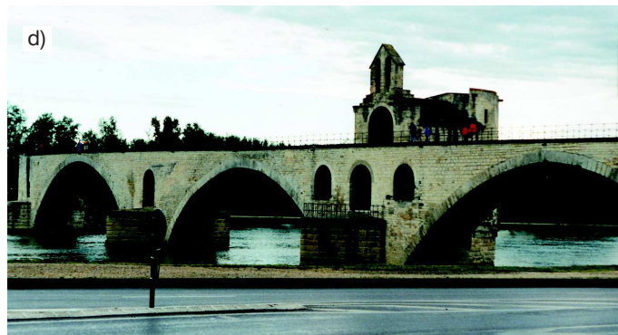
Fot. 1. Most w Avignon (fot. autora) a) tablica na murach miejskich z rysunkiem całego mostu, b-d) istniejące przęsła mostu
