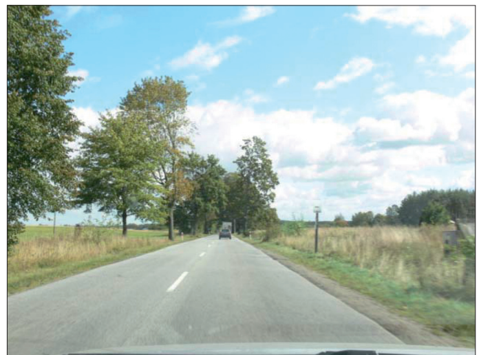
Fot. 4. Przykłady mankamentów – brak chodników i dojść do przystanków autobusowych oraz brak zatok
