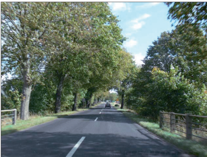
Fot. 3. Przykłady mankamentów – drzewa w bezpośrednim sąsiedztwie jezdni
