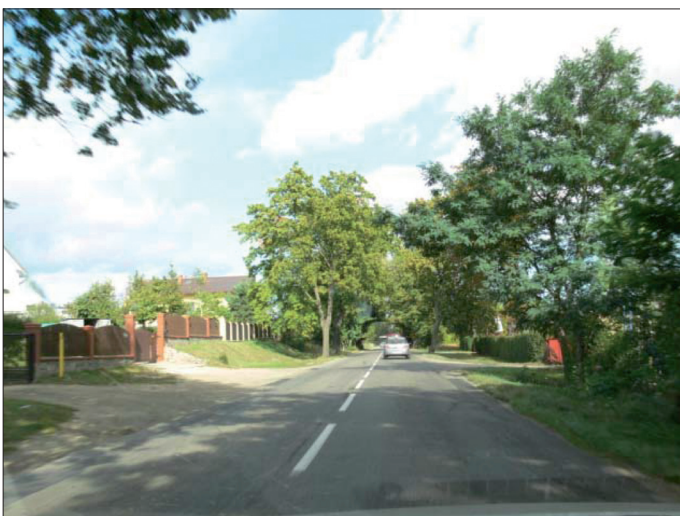
Fot. 4. Przykłady mankamentów – brak chodników i dojść do przystanków autobusowych oraz brak zatok
